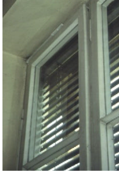
Bild 7 Stark verzogene Fenster im Gebäude 1. Die Fenster ließen sich nicht mehr vollständig schließen.
