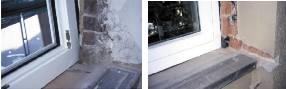
Bild 41 Beim Ausbau der alten Fenster und beim Entfernen des alten Fensteranschlages entstanden Ausbrüche, die oft nicht mit Mörtel ausgeglichen wurden und von den Kompribändern nicht abgefangen werden konnten
