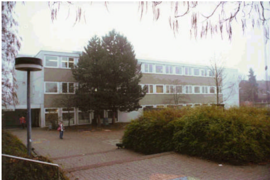
Bild 12 Südwestansicht von Gebäude 3
