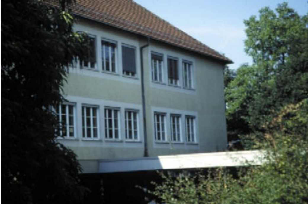
Bild 9 Ansicht der Südostfassade von Gebäude 2
