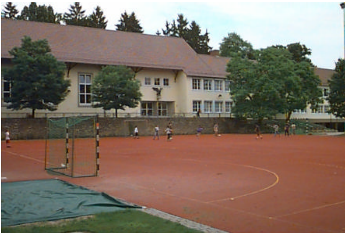
Bild 5: links die Südostansicht des Gebäudes 1 und rechts Gebäude 2
