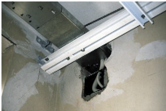
Bild 52 Ausgeführte Abhängung des Leuchtensystems
