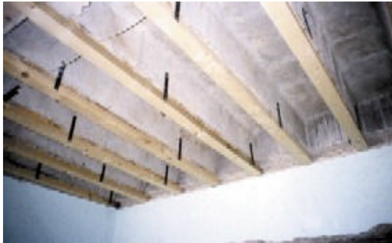
Bild 51 Ansicht der Abhängung der Decke gegen Außenluft
