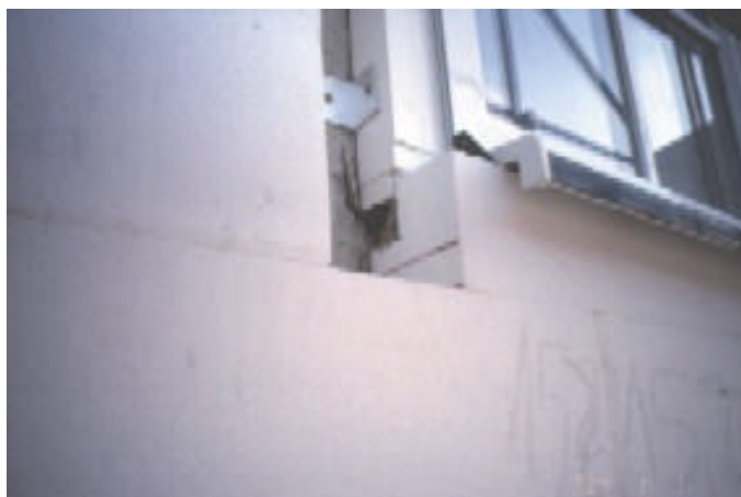
Bild 42 Das Aufsetzen der Fenster auf die alte Fassade verursachte erhöhte Aufwendungen beim Anbringen des Wärmedämmverbundsystems
