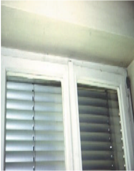
Bild 7 Stark verzogene Fenster im Gebäude 1. Die Fenster ließen sich nicht mehr vollständig schließen.
