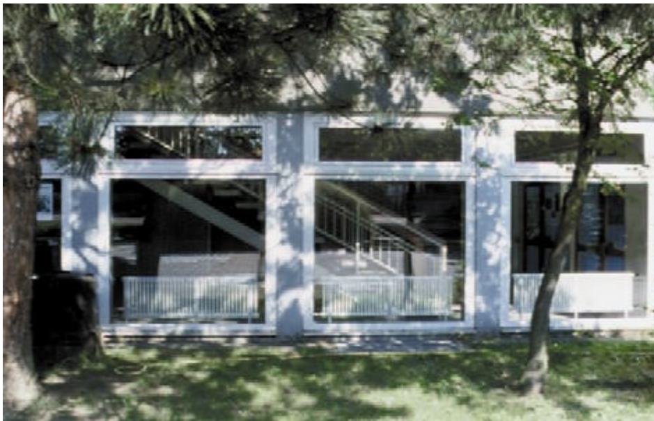
Bild 17 Klassenraum mit veralteten Leuchten (Rasteraufbauleuchten) und dunklen Raumumschließungsflächen (Holzpaneele, verschmutzte Anstriche)
