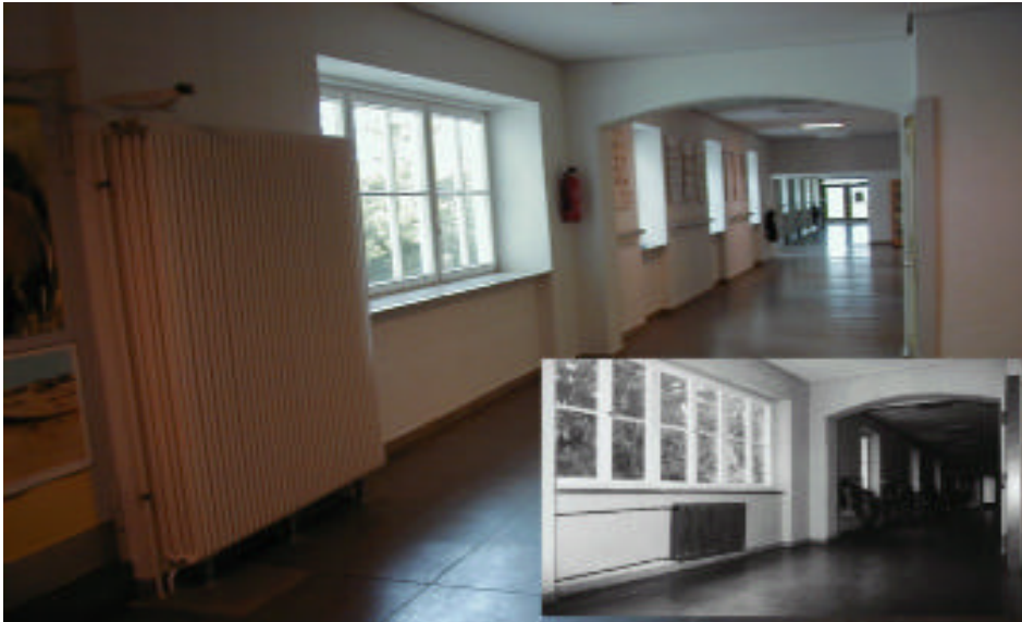
Bild 45: Anordnung des Heizkörper im Flur. Nach [30] wird hiermit lediglich Anforderungsstufe 1 erreicht, d.h. nur Deckung der Heizlast, keine Beseitigung von Behaglichkeitsdefiziten.
