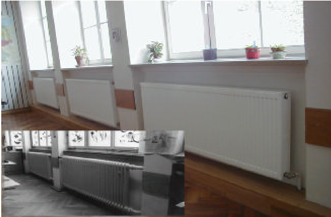
Bild 43: Heizkörper im Klassenzimmer 3 von Gebäude 1 vor und nach der Sanierung
