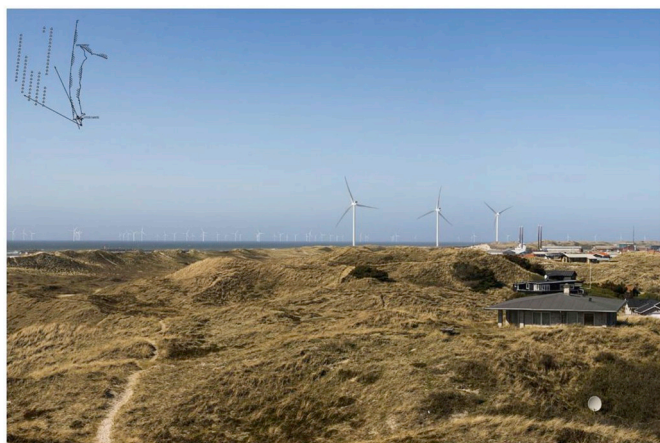
Fotostandpunkt 9: Syd for Hvide Sande - Visualisering af 66 stk. 3 MW møller (137 meter totalhøjde). Afstand til nærmeste mølle ca. 7,7 km. OBS: Kun 55 ud af de 66 møller er synlige indenfor dette fotoudsnit. Pilene indikerer eksisterende møller. 3,1 MW (144 meter totalhøjde)
