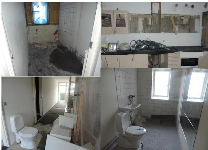
FIGUR 15. Eksempel på arbejdsområder i tilknytning til reovering af badeværelse og faldstammer i almen bebyggelse i Aarhus. Øverste billede til venstre er det afriggede gamle badeværelse med reparation af betongulv. Øverste billede til højre er køkkenet med nedtagede overskabe, så der er adgang til installationerne. Nederste billede til venstre er lagerpladsen i stuen. Nederste billede til højre er det færdige badeværelse.
