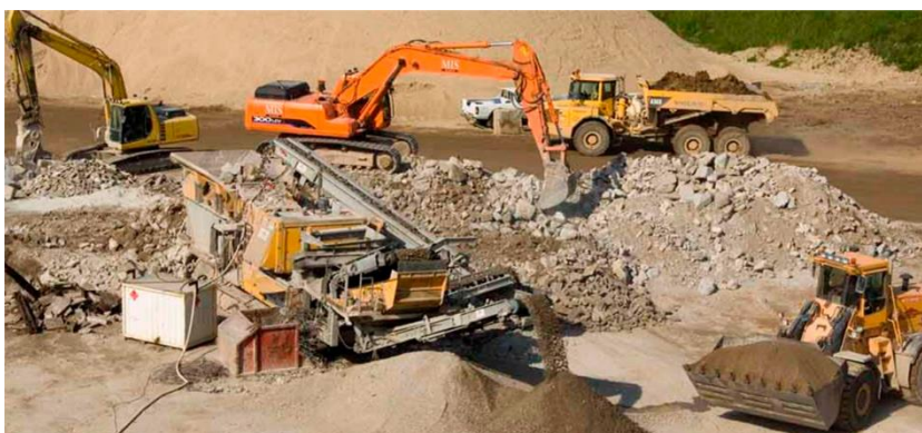
FIGUR 29. Neddeling af jord- og betonaffald. [Foto: Norrecco A/S]
