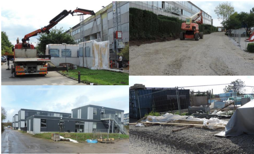
FIGUR 17. Eksempler på funktionsområder for byggelogistik på byggeplads ved renovering af almen boligbebyggelse i Aarhus. I øverste venstre billede er vist aflæsningsområde for vægelementer. I øverste højre billede er vist interimvej og parkeringsareal. I nederste venstre billede er vist skure til genhusning. I nederste højre billede er vist indhegning af lagerområde.
