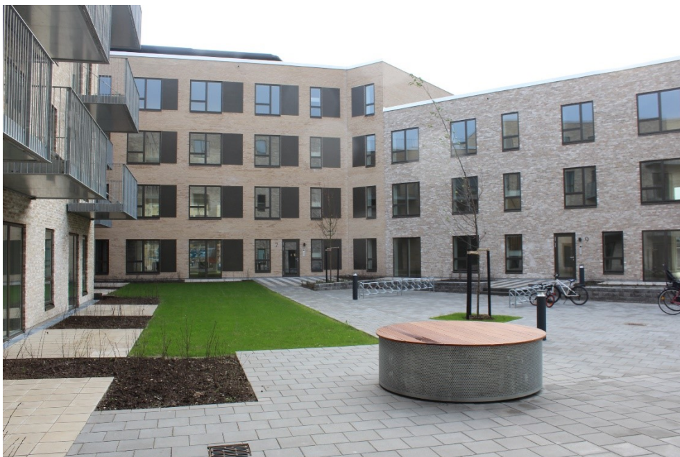
FIGUR 8. En af udluftningskanalerne.
