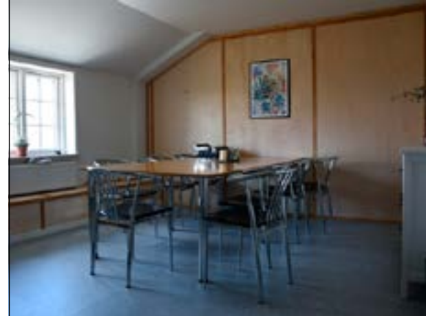
Installationsbænk til venstre og vægge af birkefiner.
