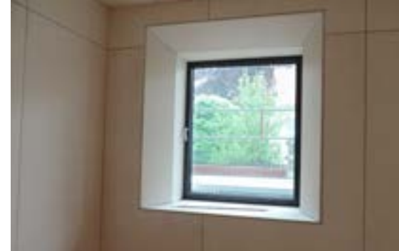
Nyt vinduer med lysning og vægpaneler i birkefiner.
