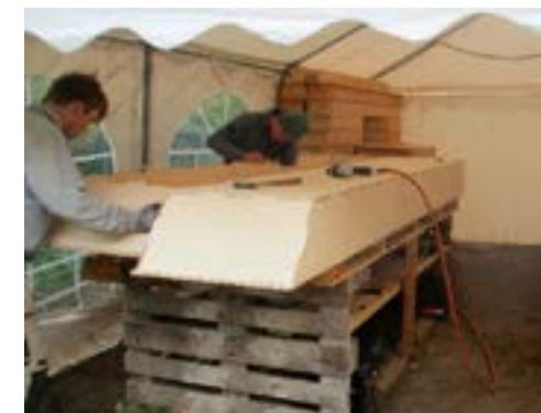
Samling af tagelement på byggepladsen, © Peter Ib Rasmussen.
