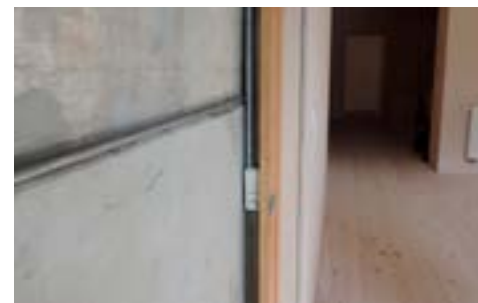
Hulrum til udluftning af forurening fra undergrund.
