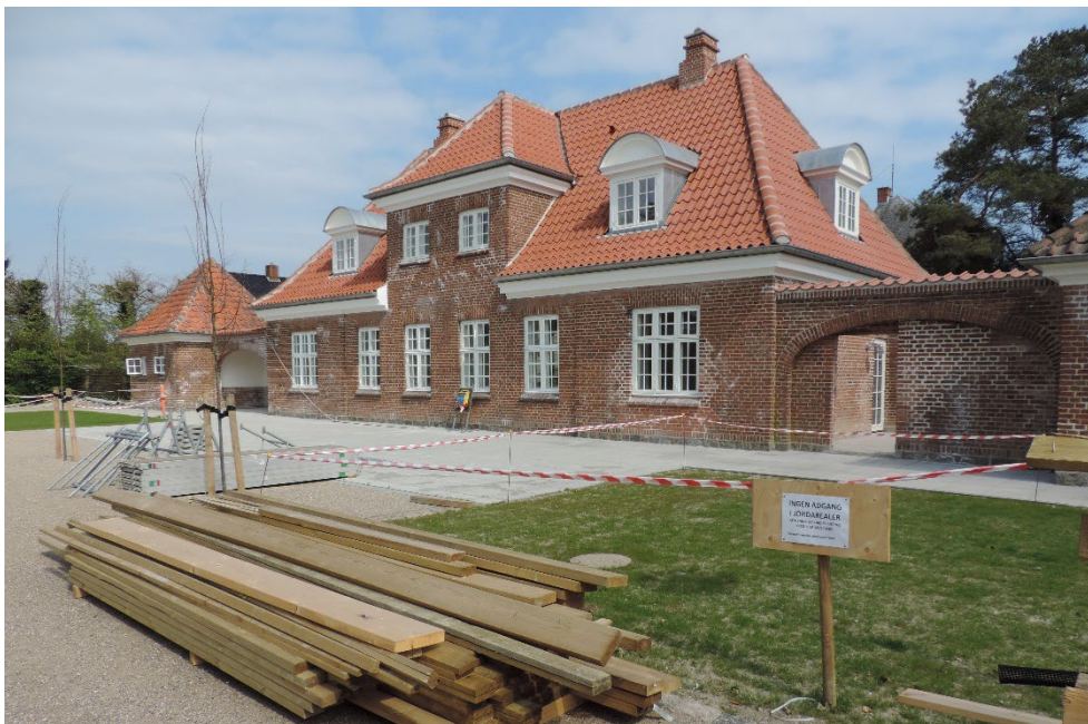
FIGUR 21. Vestfacaden af stationsbygningen ud mod perronen, hvor der er opsat 4 nye kviste som kopi af de eksisterende kviste. Foto: Niels Haldor Bertelsen (2020).
