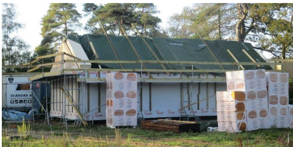
FIGUR 38. Modulhus 1 blev under opførelsen sikret mod regn. [Vordingborg, B01].
