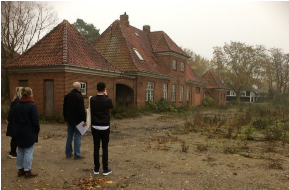
FIGUR 14. Den gamle rødstens-stationsbygning i Mern. I baggrunden ses pakhuset, og til højre ligger det gamle, nu ryddede baneterræn og perronområde, hvor modulhuse på 64 m 2 planlægges placeret. Foto: Niels Haldor Bertelsen (2018).
