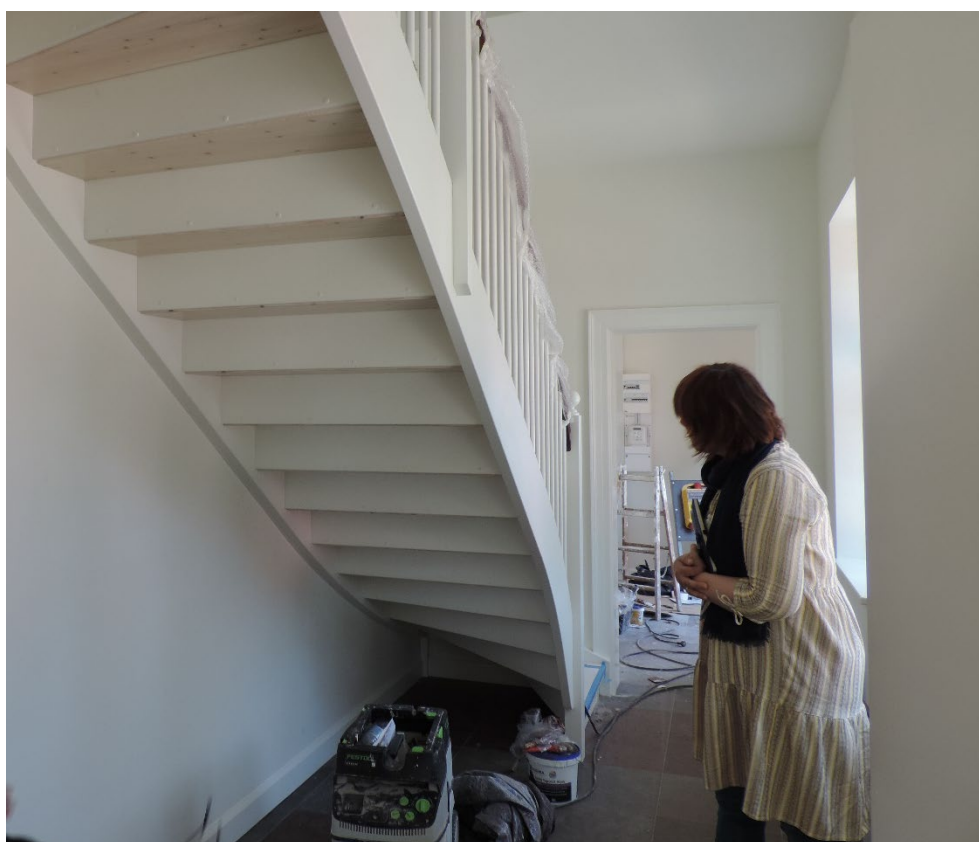
FIGUR 24. Trappeopgang i renoveret stationsbygning. Foto: Niels Haldor Bertelsen (2020).
