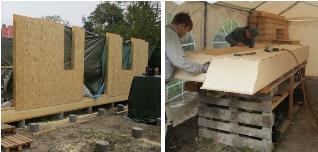
FIGUR 27. Rejsning af vægge og klargøring af tagelementer til modulhus. [Vordingborg, B01].
