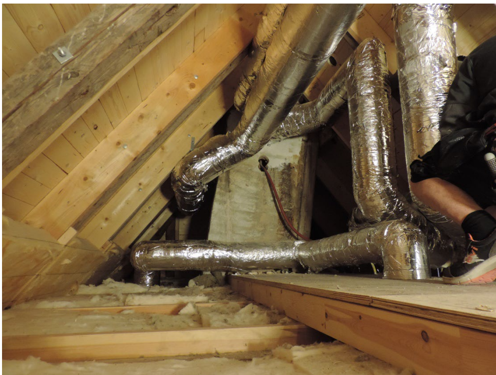
FIGUR 25. Ventilationsrør på kiploft i stationsbygning. Foto: Niels Haldor Bertelsen (2020).
