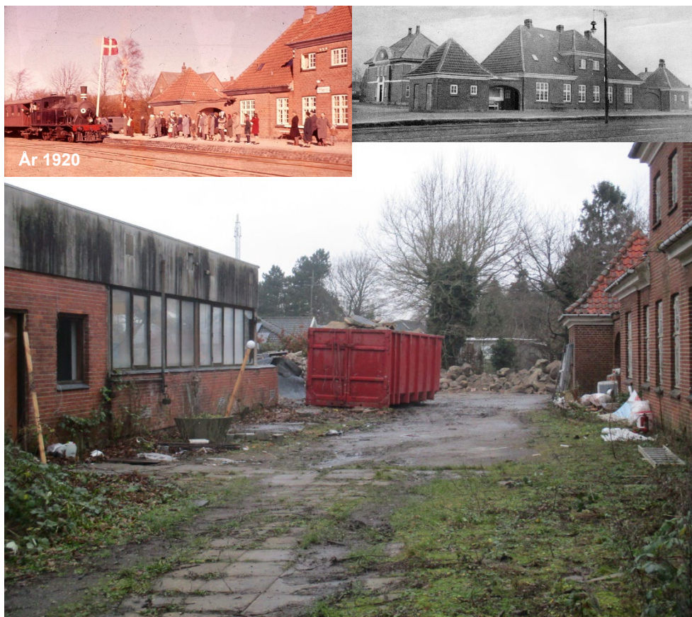
FIGUR 5. Mern Station er fra 1920 og blev lukket i 1961. Efter 60 år ser de bevaringsværdige stationsbygninger øde og forsømte ud, som det ses på nederste billede. Foto: [Vordingborg, A01] og Peter Ib Rasmussen (2017).
