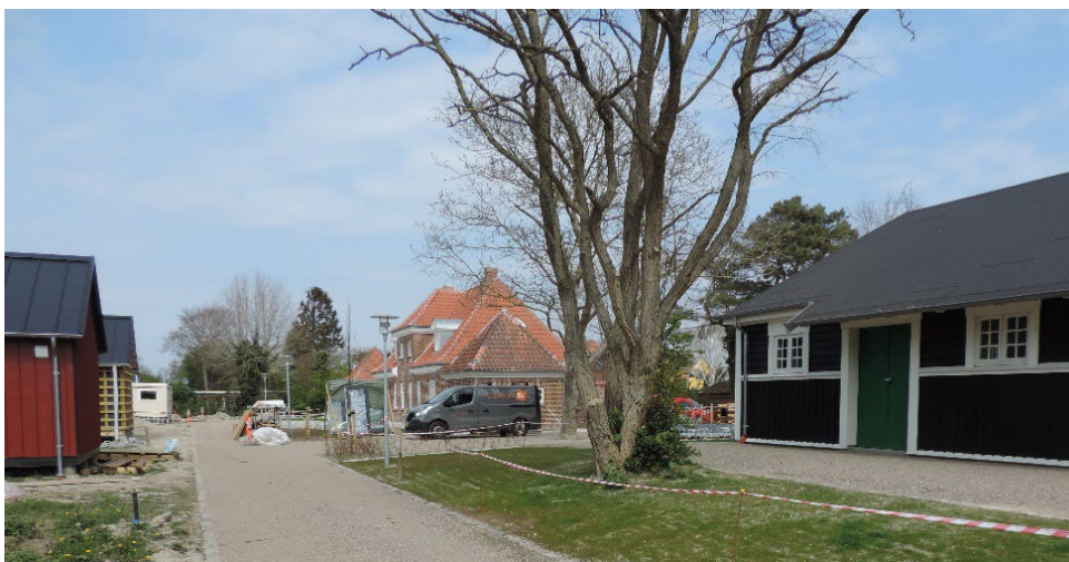
FIGUR 19. Det fælles opholdsrum mellem stationsbygningen og pakhuset til højre samt de 2 nye modulhuse til højre. Foto: Niels Haldor Bertelsen (2020).
