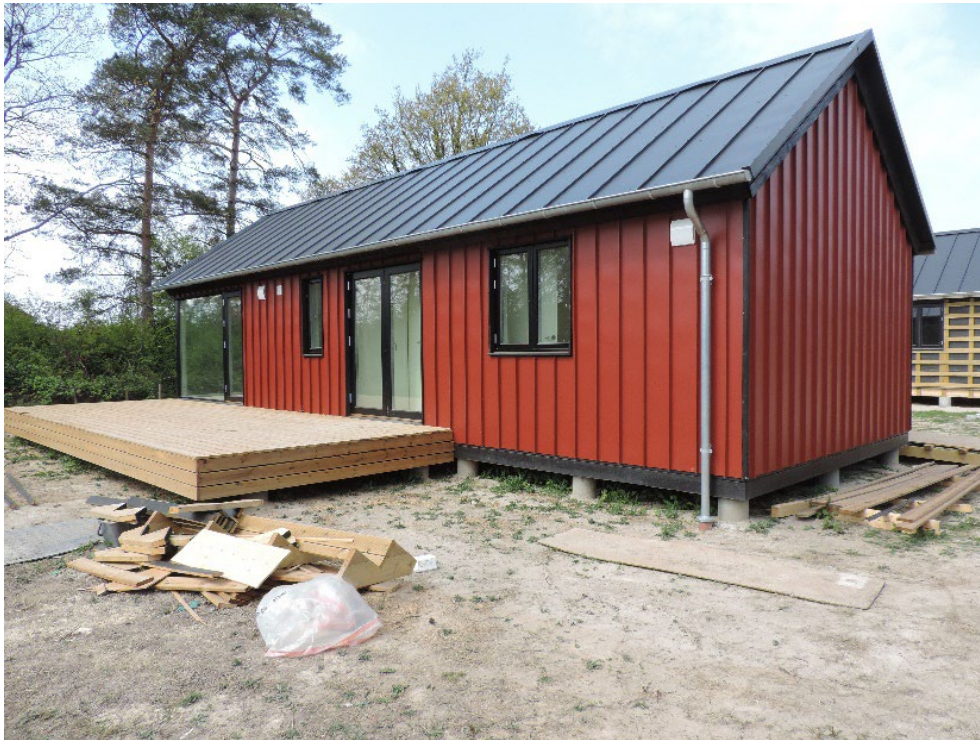
FIGUR 22. Modulhus 1 under opførelse. Foto: Niels Haldor Bertelsen (2020).
