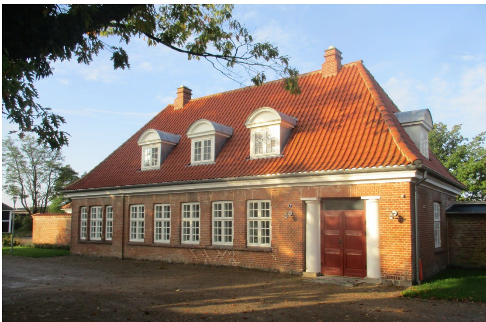
FIGUR 32. Indgangs- og østfacade på renoveret stationsbygning. Foto: Peter Ib Rasmussen (2022).
