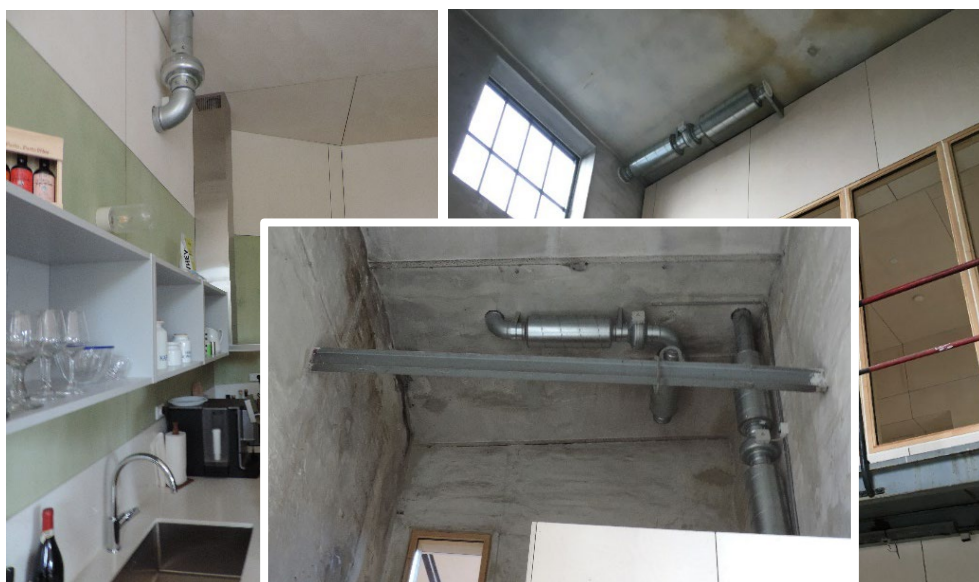
FIGUR 26. Ventilationen i køkkener og i de uopvarmede rum opleves store, klodsede og larmende. De er sidst i forsøgsprojektet suppleret med et balanceret varmegenvindingsanlæg, som kan afhjælpe problemer med afgasning fra forurennet undergrund. Foto: Niels Haldor Bertelsen (2021).
