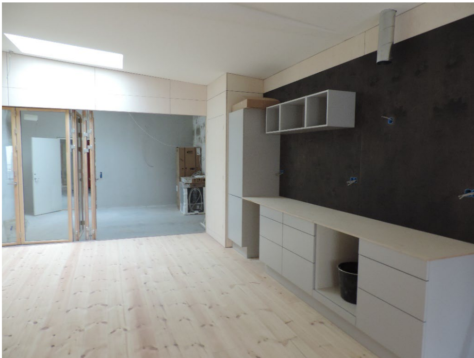
FIGUR 21. Køkkenet med udsigt til råd, uopvarmet rum. Foto: Niels Haldor Bertelsen (2020).
