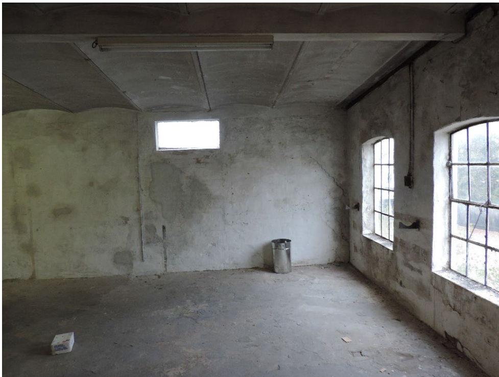
FIGUR 11. Et rå fabrikslokale med romerdæk. De gamle fabriksvinduer ønskes bevaret efter transformationen af fabrikshallerne til lejeboliger. Foto: Niels Haldor Bertelsen (2019).
