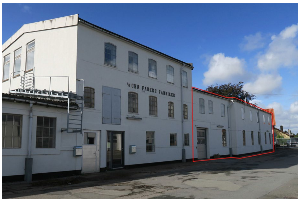
FIGUR 6. Forsøgsbyggeriet omfatter den vestlige del af de ældst bevarede produktionshaller på Fabers Fabrikker, som er fra 1920'erne. Facaden på disse produktionshaller fra 1920'erne er vist på dette billede med rødt, og på situationsplanen er det bygning 2. Kilde: [Faaborg, A03].
