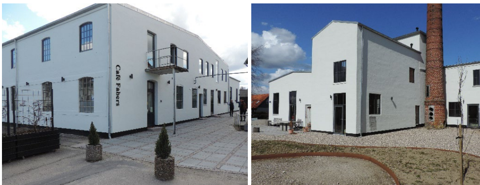
FIGUR 28. Indgangsfacaden til venstre og gårdfacaden til højre. Der er nye, sprossede vinduer ud mod parkeringsarealet, mens der er nye vinduer uden sprosser i resten af facaden. Foto: Niels Haldor Bertelsen (2021).
