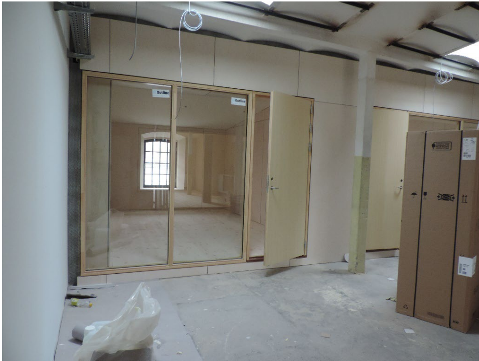
FIGUR 22. Råt, uopvarmet fællesrum med synlige installationer og romerdæk, herfra er der indkik til opvarmet boligrum og nyt vindue med sprosser, som vender mod nord. Foto: Niels Haldor Bertelsen (2020).
