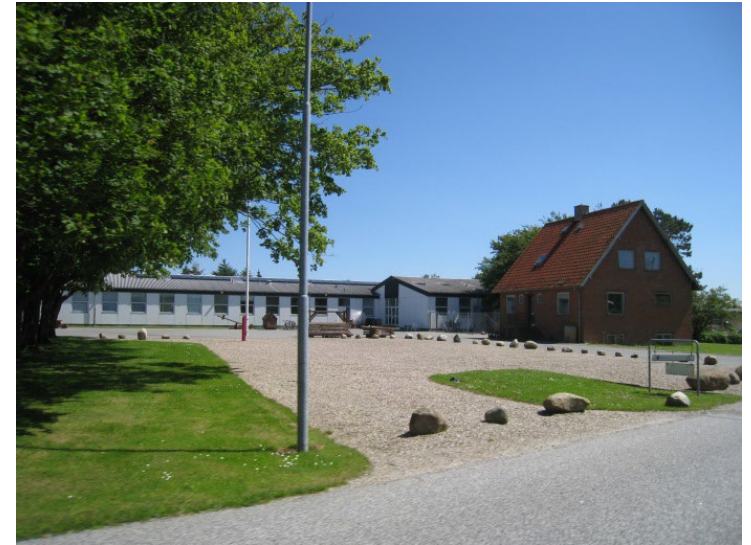
Grunde, der er ryddet foran skole i Morsø Kommune. Bygningen til højre (og en anden bygning til venstre på den anden side af skolen) forventes også nedrevet på sigt, når ejer flytter.
