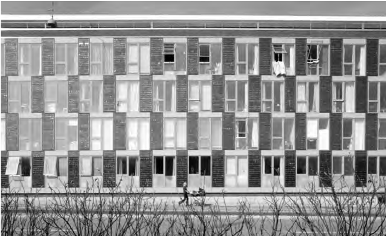
På ungdomsboligerne på Silkeborgvej i Århus er solcellerne anvendt som arkitektonisk element integreret i den sydvendte facade.
