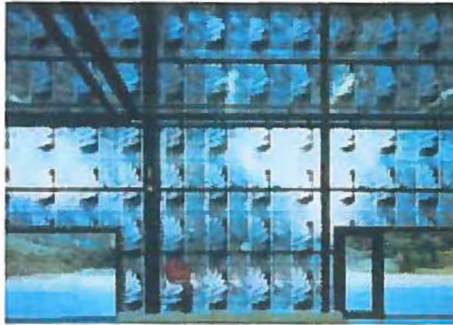
Herzog & de Meurons Ricola Factory i Mulhouse-Brunstatt, Frankrig fra 1993. Ricolas fabrik ligger i skovene ved Rhone floden. De frodige omgivelser afspejles i facademe, der er lavet af polycarbonate plader med silketryk. Det filtrerede dagslys giver et blødt og levende udtryk samt et godt arbejdsklima. (67)
