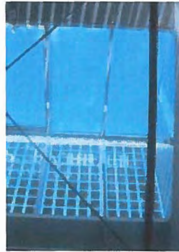
Kig op i shedtag, hvor der er blændet for det direkte lys fra syd og der derfor kun er dagslysindtag fra nord. (6)
