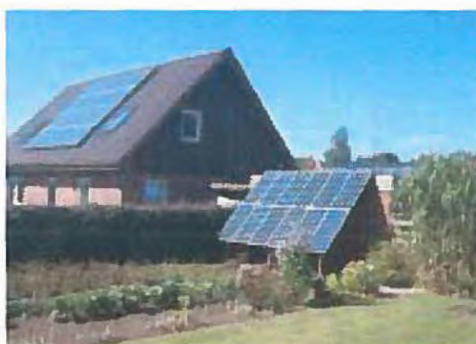
Solcelleanlæg på enfamiliehus samt som halvtag, SOL-300. (28)
