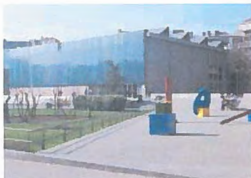
Bibliotek i Mataró, Spanien af arkitekt Miquel Brullet i Tenas. Den sydvendte facade er beklædt med polykrystallinske silicium celler. (29)
