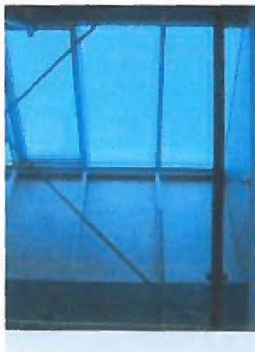
Kig op i shedtag, hvor der er blændet for det direkte lys fra syd og der derfor kun er dagslysindtag fra nord. (6)
