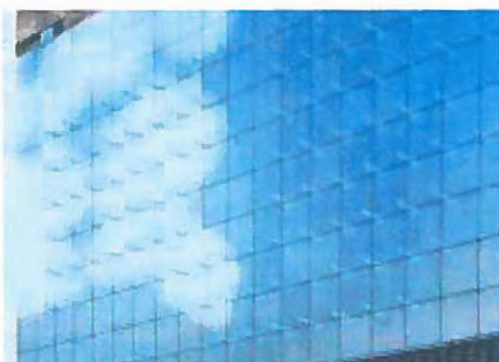
Spejlglass monteret horisontale glasfiner skaber en visuel dybde. Lysets skiftende, himlens farver og skyerne spejles i facaden og danner et spil af lyseffekter, et billede på dagens skiftende forhold i et urbant kontekst. Facaden 'Dichroic Light Field' er designet af James Carpenter i New York, USA, 1995. (25)
