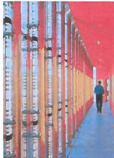
Facaden er bygget op som en termorude. Det yderste glas har en spejlende karakter, på indersiden af dette er der trykt firkantede sølv mønstre, som filtrerer lyset og skaber spil mellem lys og skygge. Trykket er for effekt, samme effekt kunne opnås med solceller. (87)
