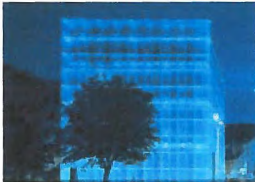
Facaden på Peter Zumthors 'Kunsthhaus Bregenz', Østrig, er beklædt med glasskiver der er friholdt konstruktionen. Glasset absorberer det skiftende lys fra himlen og refleksioner fra søen. (23)
