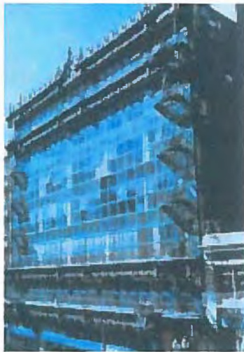
Hallidee Building i San Francisco, USA fra 1893 er et eksempel på en af de første curtainwalls. Bygningen er en jembetonkonstruktion, hvorpå facaden er ophængt i en stålramme. Arkitekten Willis Polk skabte facaden som et resultat af udviklingen indenfor jembeton- og stålindustrien. (43)
