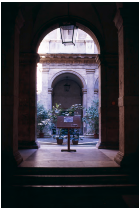
Fig. 1.52 Når man står i portrummet, lige midt imellem porten og gården, flugter kapitælerne på pillerne i loggiaen stadig med gesimsledet mellem stuen og 1.sal på gårdens modsatte side. Forklaringen er at gulvet i porten har samme hældning som vinklen mellem en persons øjenhøjde lige indenfor porten til kapitælerne og gesimsen inde i gården.
