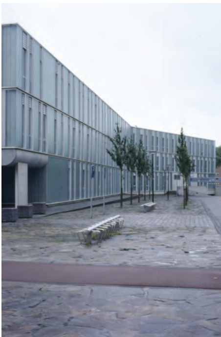
Fig. 3. 65 Administrationsbygningens facade. Her er der høje smalle vinduer med en vekslende afstand, i modsætning til de større vinduer og vinduesbånd i den øvrige bygning.
