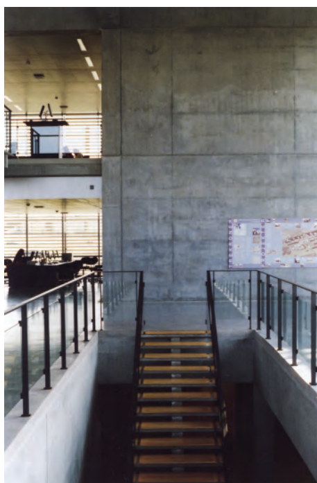
Fig. 3.38 Støbefugerne i væggen længst mod vest følger ikke de vandrette delinger i rummet, bortset fra den midterste fuge, som deler væggen i en øvre og en nedre del. Den ligger i samme niveau som dækket mellem stue og 1.sal. På rammen som står opad væggen, er denne linie fræset ud, efter at være støbt. Også rækværkets overkant på 1.sal der slutter 1 cm under en støbefuge i den lodrette ramme, som rækværket støder op til, fig. 3.8.
