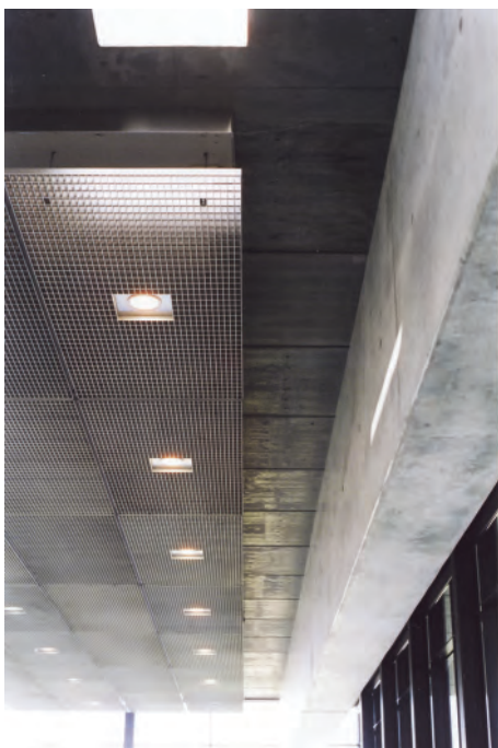
Fig. 3.40 De nedhængte metalnet i loftet er en frit hængende flade, som ikke er lukket langs kanten og har afstand til rammerne. Det er et generelt princip i salen at hver del er et uafhængigt element, og er markeret som sådan: Rammerne står frit, fig. 3.5, med I-profiler skabes en afstand mellem rammerne og glasfacaden, fig. 3.9. Loftet hviler på rammerne, men med en bjælke imellem. På trapperne er det tydeligt at aflæse hvert enkelt element, trin, vange, repos osv., fig.3.6.
