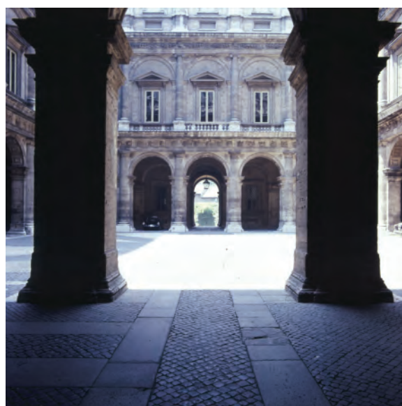
Fig. 1.33 Helt fremme, ud for baglinjen af pillerne mellem vestibule og loggia, åbner gårdrummet sig foran én. Pillerne indrammer de tre midterste fag på den modsatte side, som igen indrammer tre fag på bagvæggen. Toppen af kapitælerne flugter med underkanten af gesimsen mellem 1. og 2.sal, og toppen af den nederste kapitæl flugter med pilastrener kapitæler på 1.sal.
