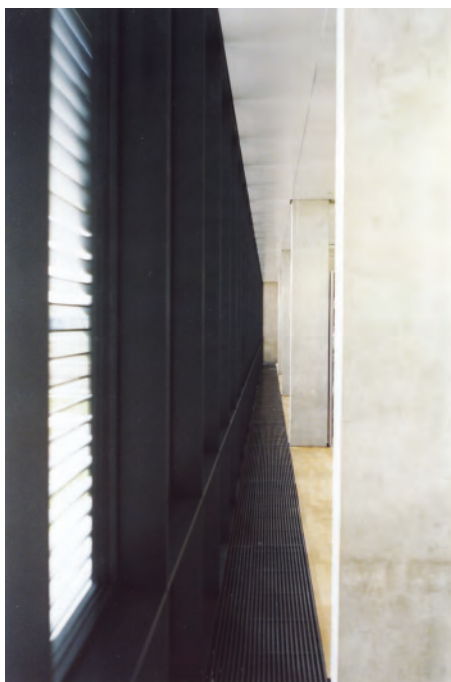
Fig. 3.39 Et er et generelt princip i længen at delene følger sig efter hinanden: I det ydre ligger vinduesrammen i plan med murfladen. I kontorerne i længen ligger radiatorerne i indrykkede felter, så væggen plan og radiatorens plan slugter. De højsiddende vinduer ind til kontorerne ligger i plan med de vægge de er afslutningen på. Dørene i de tværgående vægge, som adskiller enderne af længen fra den åbne midte, ligger også med dørbladet i plan med væggen.
