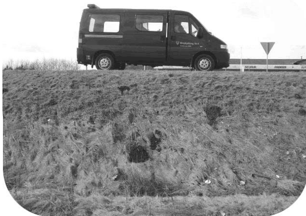
Figur 47. Dyb grøft i strækningens østlige side ved km 51,35.
