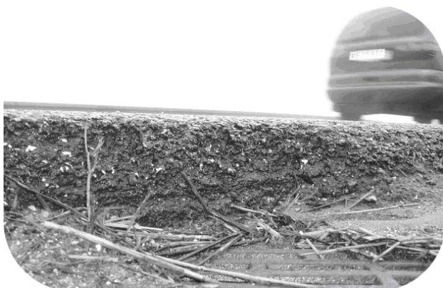
Figur 60. Høj kant og brønddæksel i strækningens sydlige side i km 2,38.
