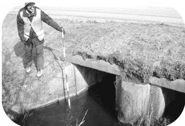
Figur 51. Vandunderløb i strækningens vestlige side ved km 7,98.
