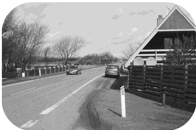
Figur 45. Bygværker, indkørsler, parkeret bil og fodgængere ved km 50,98
