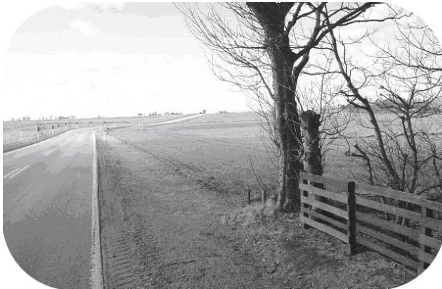
Figur 57. Træ i strækningens nordlige side i km 1,37.
