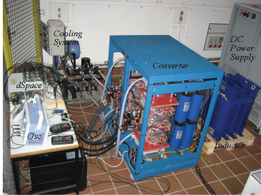
Fig. 19. Test setup photo
