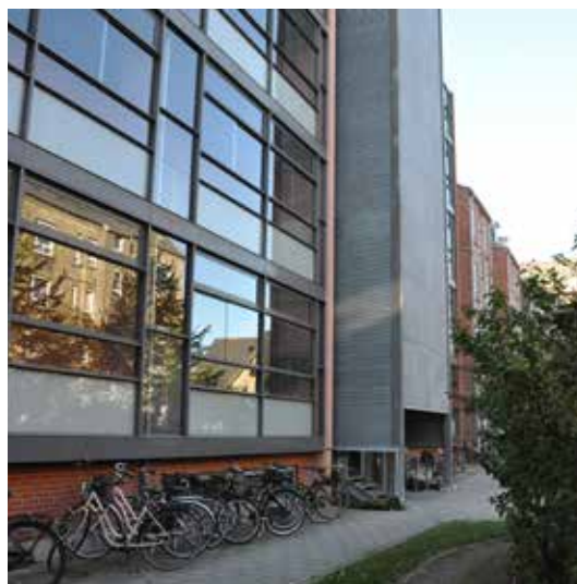
Det grønne hus' facade mod gården i 'karre 5'
