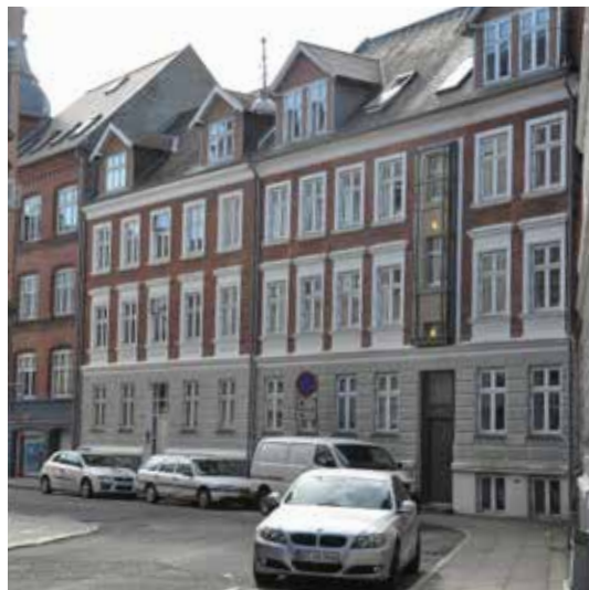
Gadefacaden på 'det gule hus' i Christiansgade
