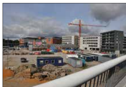
2013 - Kennedy Arkaden som en del af Godsbanerarealet under udbygning
