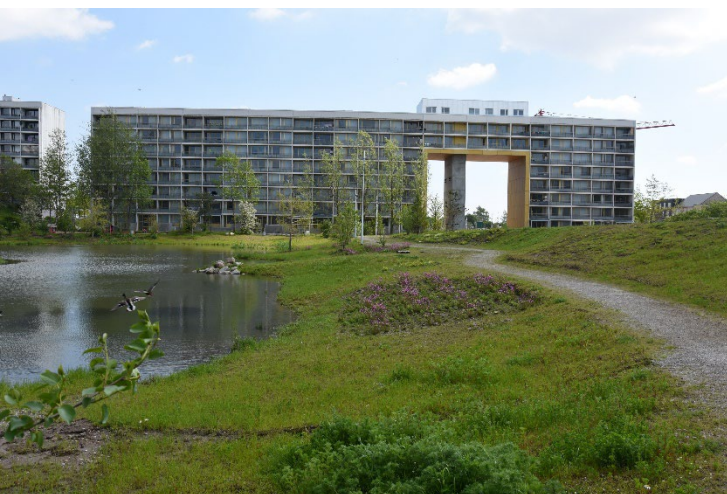
Renovering af tre blokke var igangsat. I denne er der lavet et portrum ud mod Åby Ringvej. Byparken var delvist udført i 2019.
