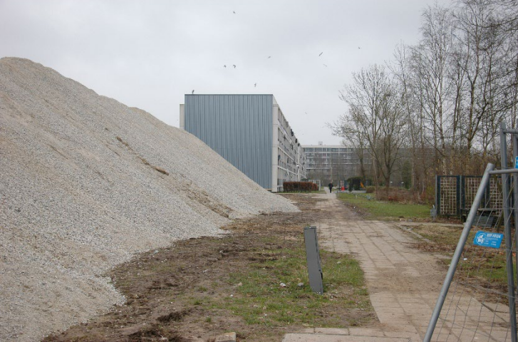
Fra 2014-2019 er der nedrevet fem boligblokke (300 boliger). Her resterne fra en nedrevet boligblok fotograferet i 2015
