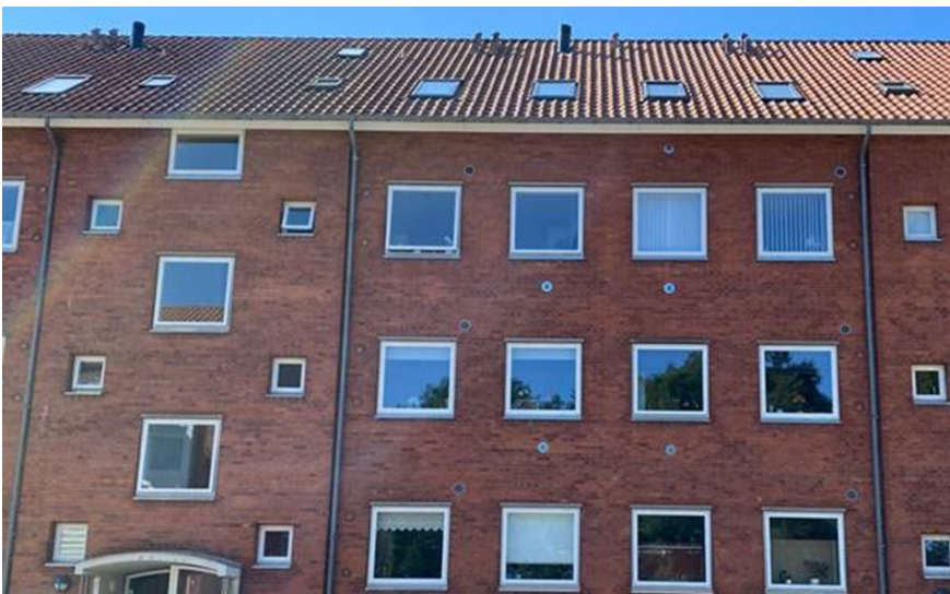
Figur 9. Billede af facade med emhætteafkast skråt over køkkenvinduer og luftindtag til behovsstyret udsugningsventilation centralt under værelsesvinduer. Foto: Mads Gudmand-Høyer.
