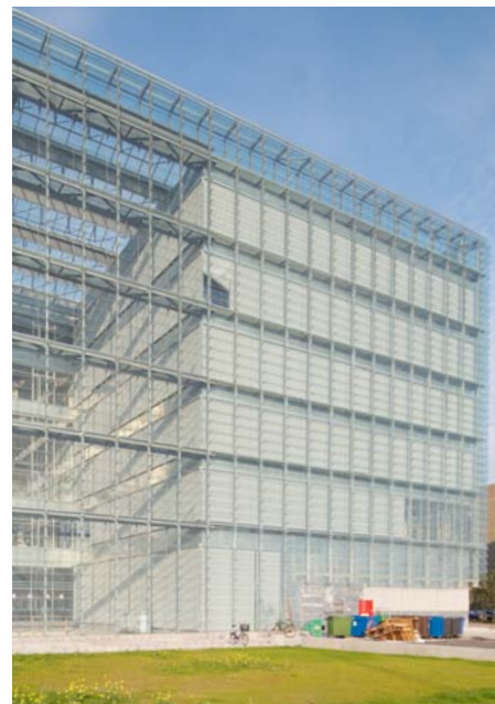
Kompakt, varmebesparende bygning med højt elforbrug DR Byen, Ørestad, 2006
