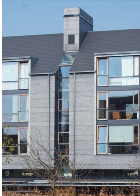
Etageboliger med fokus på tilgængelige installationer Prinsessegade, Christianshavn, 2000
