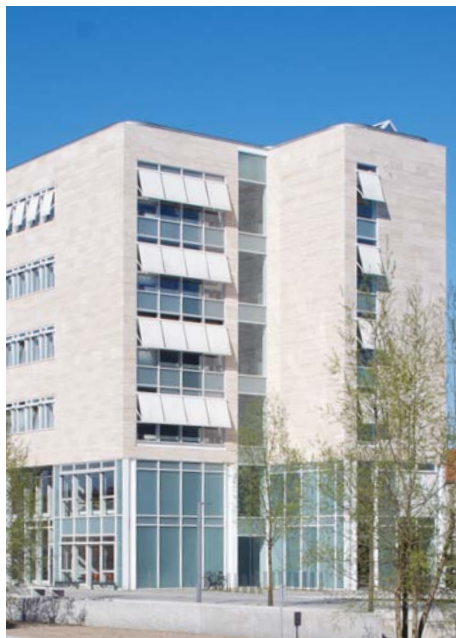
Glaspartier optimeret til dagslys og med udvendig, bevægelig solafskærmning Københavns Universitet, Amager, 2003
