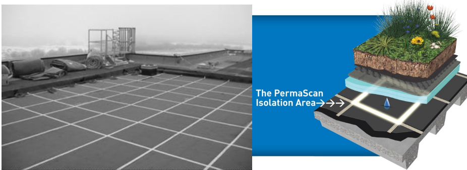
Figur 17. (a) letvægtstrådnet, og (b) implementering af letvægtstrådnet i tagkonstruktion. Kilde: Udlånt af Detec Systems LLC, PO Box 31725, Bellingham, WA 98228, USA
