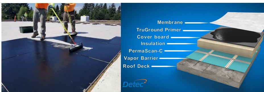
Figur 18. (a) elektrisk ledende primer, og (b) implementering af primer i tagkonstruktion. Kilde: Udlånt af Detec Systems LLC, PO Box 31725, Bellingham, WA 98228, USA
