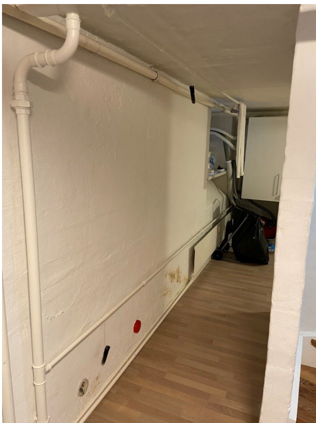
FIGUR 29. Placering af fugthætter og indeklimalogger på/ved kælderydervæg og under loft.
