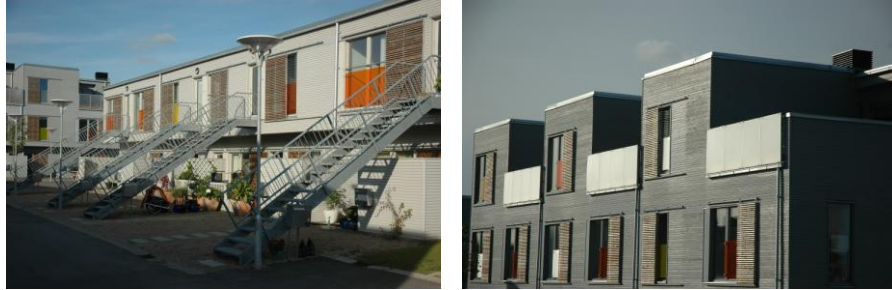
Figur: Til højre billede fra en af ankomstgaderne. Til højre de store altaner i tredje sals højde.
