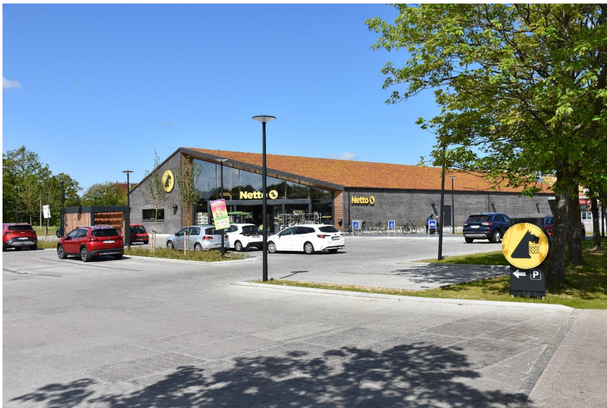
Øverst: Enkelte steder ses private haver, der på de fælles arealer, hvilket skaber variation i området. Nederst: Den nye Netto med græs på taget.
