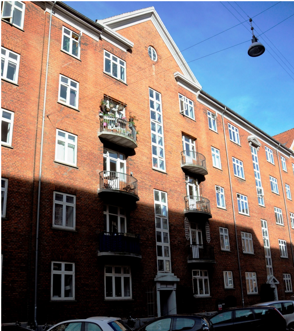
FIGUR 12. En af opgangene før renoveringen.
