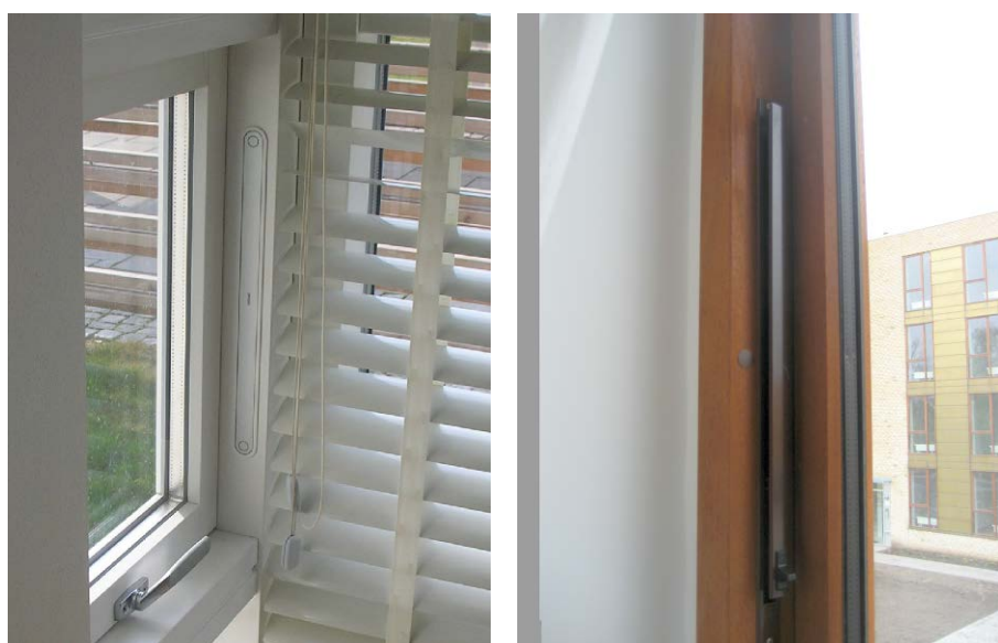
Figur 25. Almindeligt anvendte spalteventiler.
