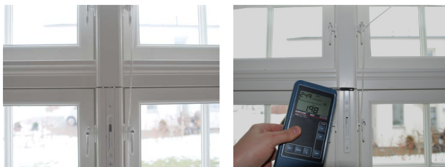
Figur 17. Ikke blot utæthed, men egentligt hul til det fri ved særlig lodpost i vindue (hus 16).
