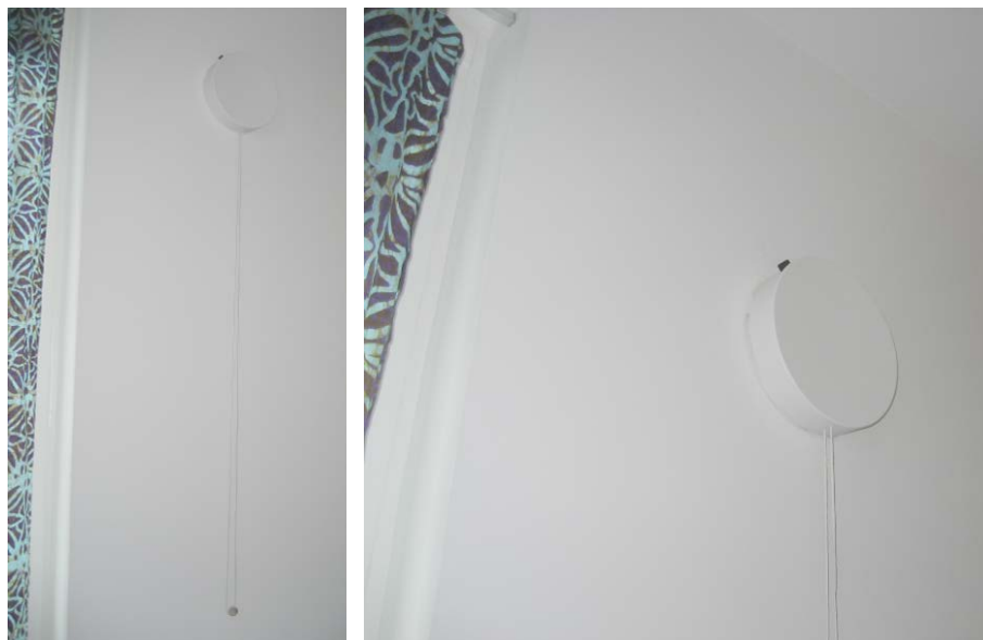
Figur 24. Cirkulær ventil med opadvendt åbning (lejlighed nr. 4).
