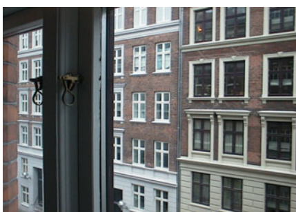
B. Byfornyet ejendom, Eriksgade 11 Bygherre: Byfornyelse København Arkitekt: AI-Gruppen
