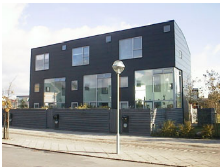
A. Alment byggeri, Tøndehvælvet Bygherre: KAB Bygge- og Ejendomsadministration Arkitekt: Tegnestuen Vandkunsten
