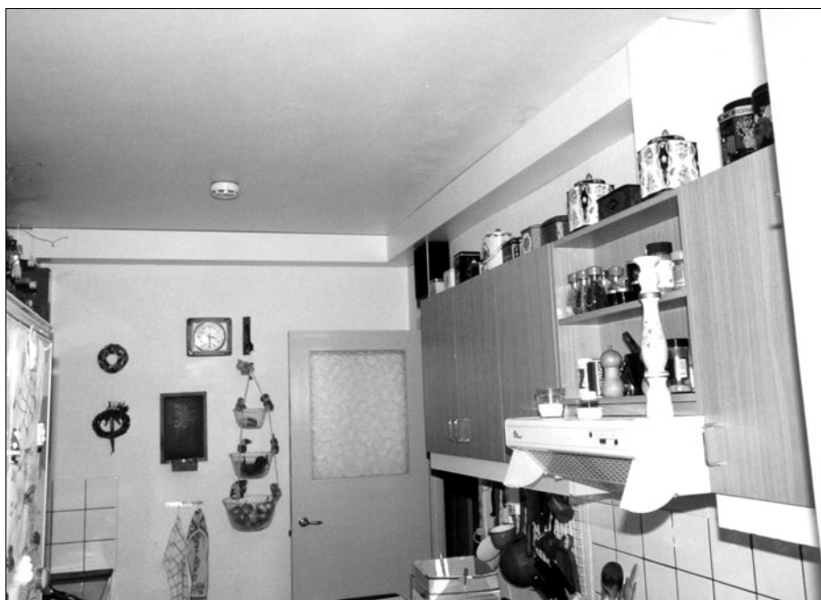
Figur 7. I to boliger, en forsøgsbolig og en referencebolig, var der en emhætte i køkkenet. I begge tilfælde var kanalen mellem emhætten og aftrækskanalen 5-6 m lang og ført i en inddækning langs loftet.
