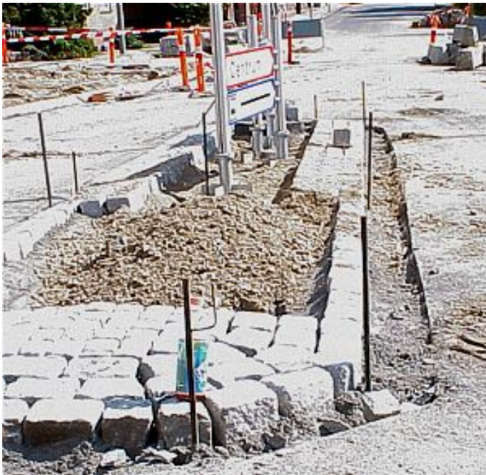
Figur 19. Eksempel på afsætning af flisearbejde i faget 'Nivellering og afsætning'.
