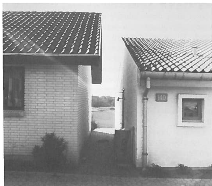
En smal privat passage er opstået, fordi sammenbygning ikke var et krav. Begge huse skal have brandadskillende gavl mod skel. Huset til højre har en brandsikret dør, der åbner ud over egen grund. Dalgården i Værløse.
