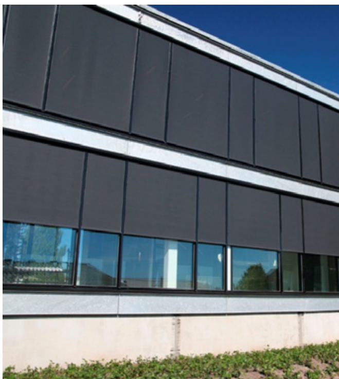
Figur 17. Facade med screens i form af rullegardiner. Den aktuelle type screen (farve, åbningsgrad m.m.) må vælges omhyggeligt ud fra krav om bevarelse af udsyn og beskyttelse mod blænding. Foto: Blendex.
