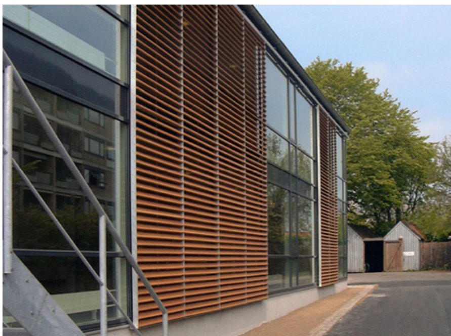
Figur 27. Dobbelt høje lamel-skodder på plejeboliger Kløckershøve i Gentofte. Foto: Art Andersen.
