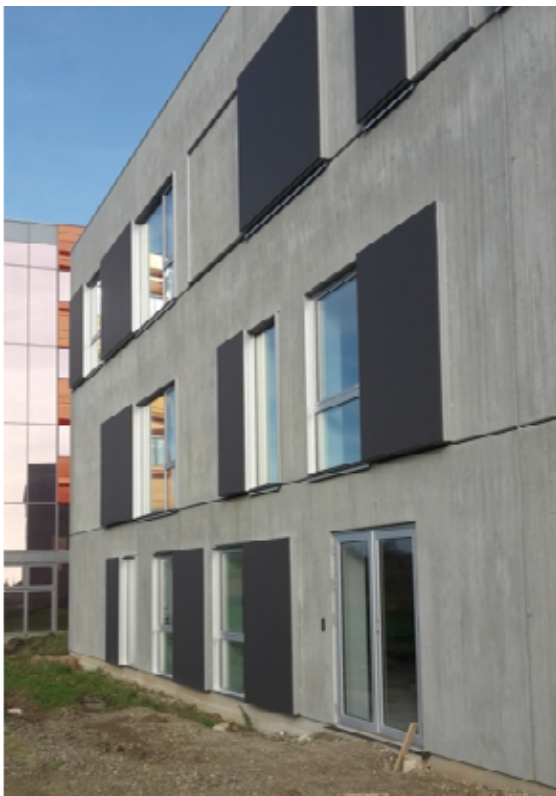
Figur 23. Fotos af sydvestfacaden i Green Tech Lab-bygningen kort efter den officielle indvielse i oktober 2014.
