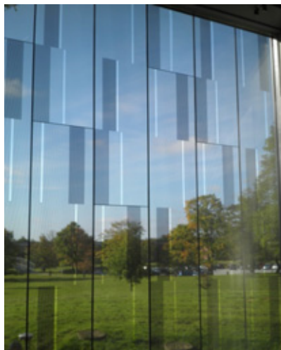
Figur 7. Facade med lyse afskærmninger, der reflekterer lyset og derfor reducerer indsynet i dagtimerne. Er der aktivitet i bygningen om aftenen eller om natten, vil denne type afskærmning ikke fungere, fordi der vil være lysere indenfor end udenfor. Foto: Microshade
