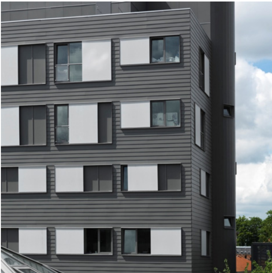
Figur 20. Afprøvning af rammesystem med screendug på midlertidig pavillonbygning opført i forbindelse med udvidelsen af Rigshospitalet. Foto: Art Andersen.
