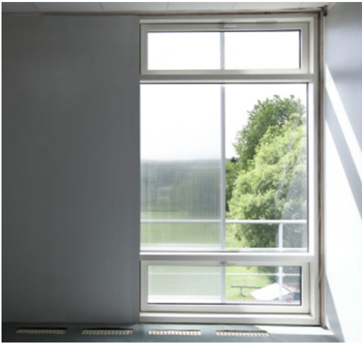
Figur 34. Energy Frames element, der både varmeisolerer og tillader dagslyset at passere. Foto: Forfatterne.
