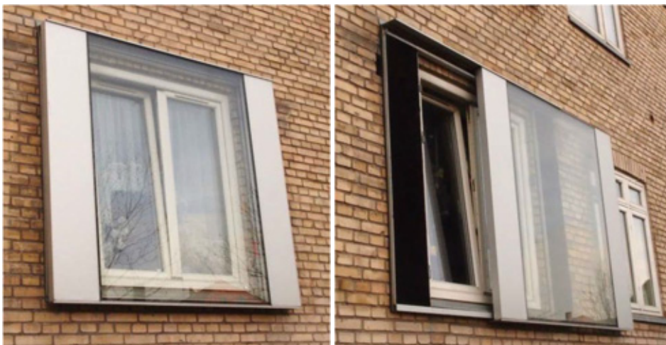
Figur 46. Fotos af lydskoddens udseende og funktion. På fotoet til venstre ses den lukkede lydskodde, til højre lydskodden kørt til siden. På begge fotos er det eksisterende side-bundhængte, indadgående vindue åbnet i ventilationsstilling. Foto: Art Andersen.
