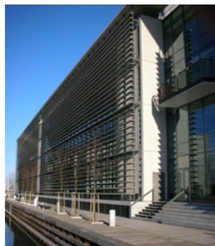
Figur 15. Bygning med faste vandrette lameller, som reducerer både dagslyset og det positive solvarmetilskud om vinteren.
