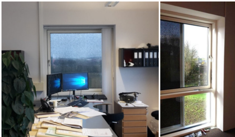
Figur 24. Foto fra lokalet med dynamiske skodder med en grå screendug. Til højre set indefra et af lab-kontorerne i stueetagen med Energy Frames elementet kørt halvt for vinduet.
