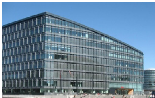
Figur 5. Bygning med store glasfacader, der i teorien giver et godt udsyn, men som i praksis må beskyttes med screendug, som foringer eller i værste fald blokerer for udsynet.
