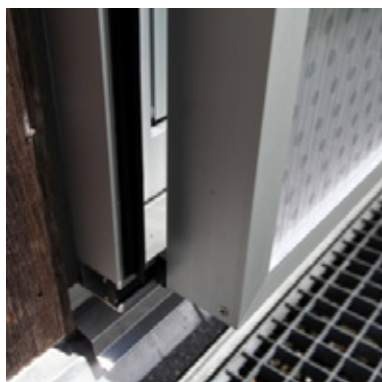
Figur 29. Ramme-elementet bevæger sig vandret på facaden ved hjælp af en motor.
