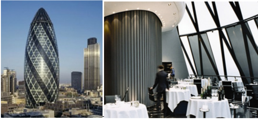
Figur 19. Manuelt bevægelige tekstilrammer i Swiss Re, London. Panelerne giver kontrol med lysindfaldet i Londons højst beliggende restaurant. Gæsterne kan nyde udsigten ud igennem panelerne, selv når de er trukket for. Men panelerne kan også køres helt væk og parkeres i magasin, når der ikke er brug for dem. Fotos: Art Andersen.
