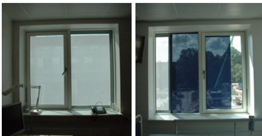
Figur 22. Foto af de to typer screendug, der blev monteret på pavillonbygningen på Rigshospitalet. Der er markant forskel på udsynet gennem de to typer, idet den hvide screendug tillader for meget stråling at passere som diffust lys, hvilket forhindrer udsyn og medfører blænding.
