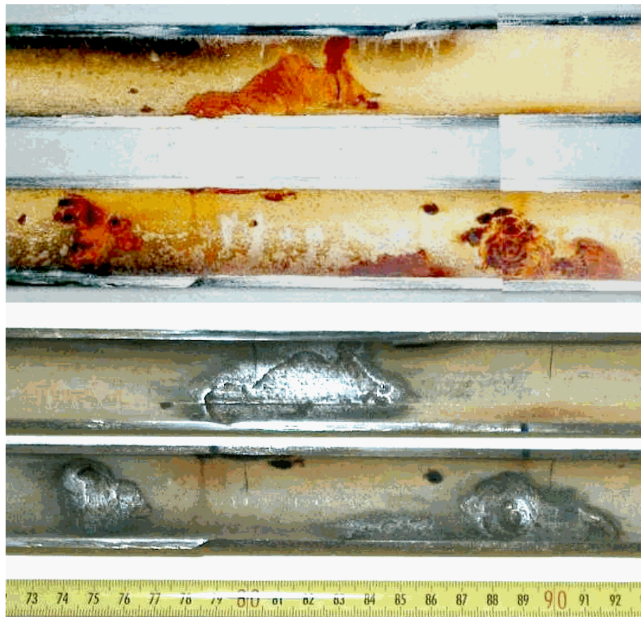
Figur 4. Forstørret billede af den del af røret, fra 8,72 - 9,93 m, der har størst negativt potentiale. Øverst ses de porøse rødlige rustbelæggninger, og nederst er belæggningerne fjernet, så man kan se tre dybe grubetæringer i afstanden 8,75, 8,79 og 8,89 m.
