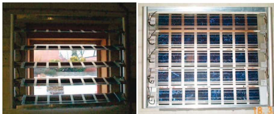
Figur 29. Fra lamelmontagen hos Dasolas, hvor man får en fornemmelse af ubehaget ved ved at se ud pga. de store kontraster. Til højre det helt 'lukkede' system, med solcellerne drejet indad. Dette vil svare til, hvordan systemet ofte vil ses udefra, når der er maksimal afskærmning.
