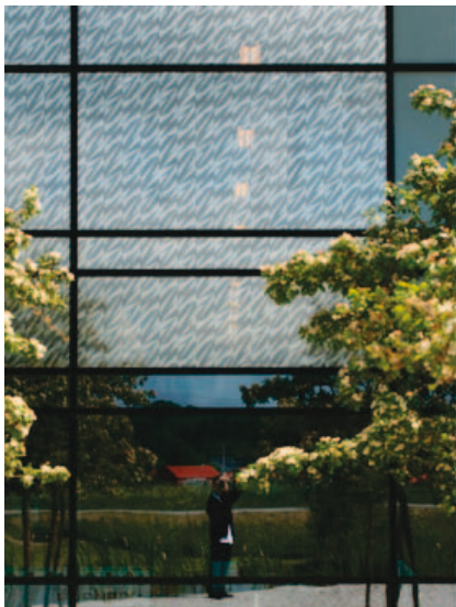
Figur 9. Afskærmning med mikrolameller i bånd af rustfrit stål. Mikrolamellerne kan udføres med flere mønstre (Photosolar).
