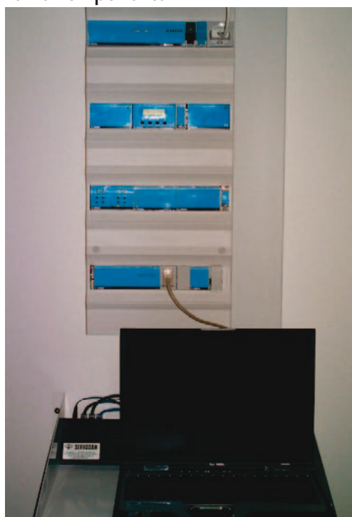
Figur 61. Foto af styringstavle med den midlertidige styring via en laptop. I den endelige udformning var det tanken, at kontrolenheden skulle indbygges i en lille boks monteret på væggen.
