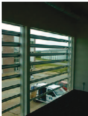
Figur 10. Billederne viser ALU PV systemet i færdig udførelse i Studenterhuset i Herning opført i foråret 2003. Projektet, som er støttet af Energistyrelsens "BIPV program", er blandt andet en demonstration af dette projekts udviklede Al lameller. Billederne viser ALU PV systemet i færdig udførelse.
