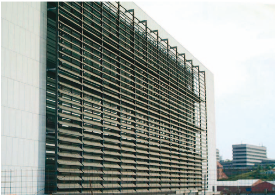
Figur 41. Foto af sydfacaden på Syddansk Universitet i Sønderborg, hvor prøvekontorerne er placeret ca. midt i billedet (med lidt mere åbne lameller end de øvrige kontorer, som har fast lamelhældning).
