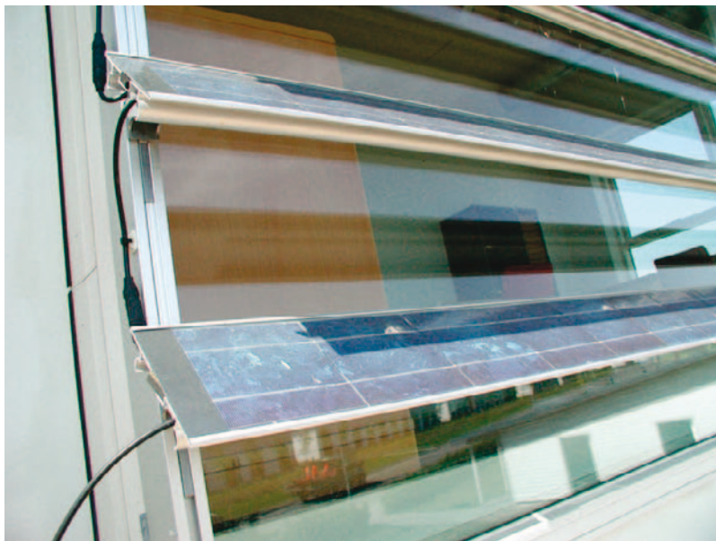
Figur 24. Lamellerne, som de der er anvendt på Studenterhuset i Herning indgik i overvejelserne, men blev fundet mindre egnede og ikke arkitektonisk attraktive. Billedet viser tydeligt problemet med egenskygger på lamellerne.
