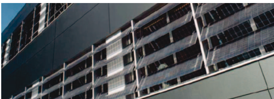
Figur 21. Solceller integrerede i glaslameller (Colt).
