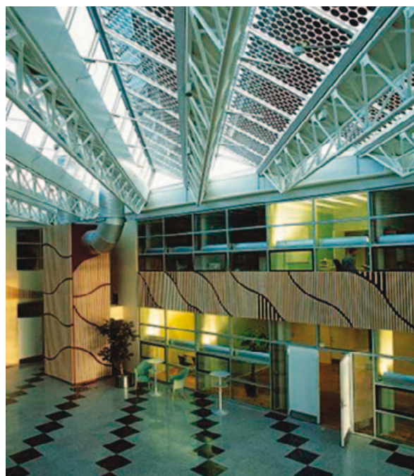
Figur 4. Atriet i Brundtland Centret i Toftlund. De delvis transparente solceller er monteret i taget af atriet, så der opnås en fast dæmpning af den del af sollyset, der kommer gennem panelerne.
