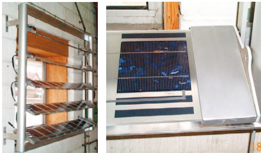
Figur 28. Montage af lamelsystemet hos Dasolas. Til højre detalje vedr. inddækning.
