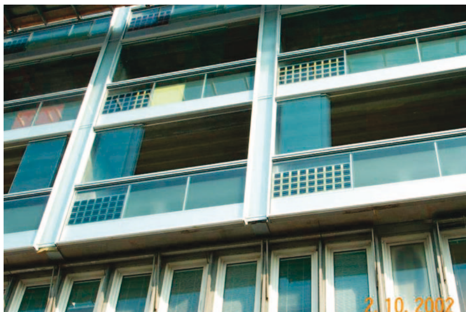
Figur 16. Solceller bag glas i facaden på Kollektivhuset på Hans Knudsens Plads, København.
