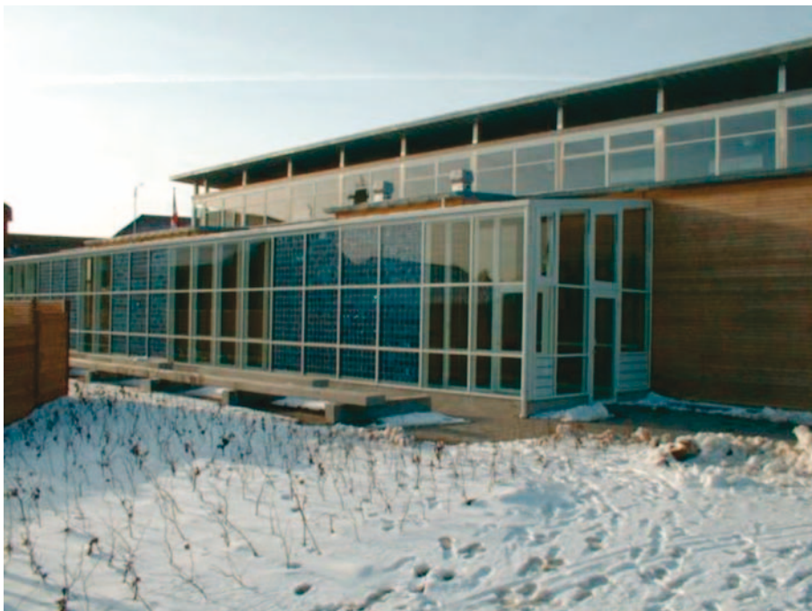
Figur 17. Kvarterhuset i Kolding opført i sommeren 2001. Projektet, som er støttet af Energistyrelsens "BIPV program", havde til formål at lave semitransparante solcellepaneler uden boks på bagsiden, samt kabelføring i rammeprofilet.
