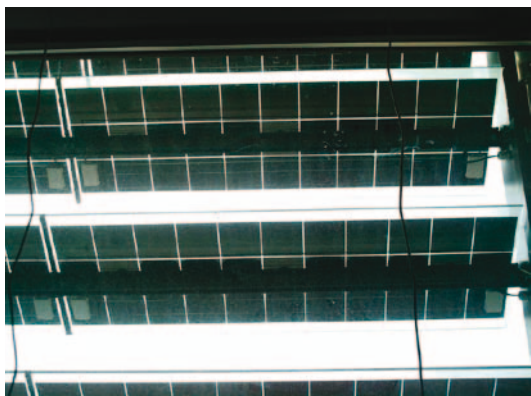
Figur 23. Flere arkitekter var opmærksomme på det potentielle problem med blænding, der kan opstå pga. for stor kontrast mellem solcelle og de åbne områder af afskærmningen.
