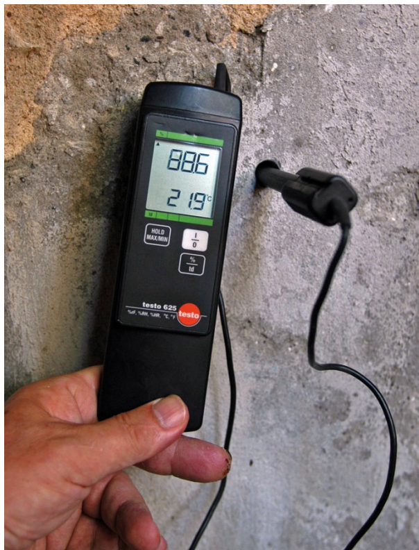
Figur 9. Måling af ligevægtsfugt i borehul i betonvæg. Hullet skal renses godt, og der skal ventes i lang tid – flere døgn – før der er fugtligevægt mellem luften i borehullet og det omgivende materiale. Først når der er ligevægt, kan der måles korrekt (Brandt, 2013).
