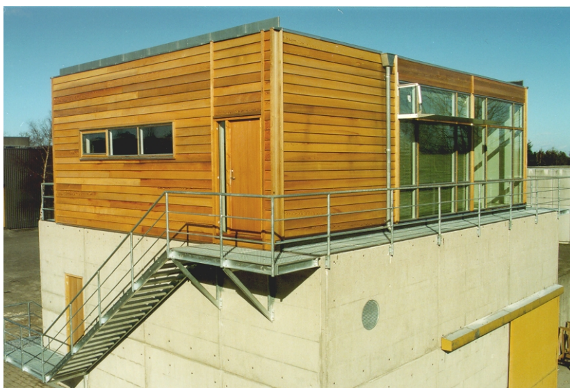
Figur 1. SBI's lyslaboratorium i Hørsholm.
