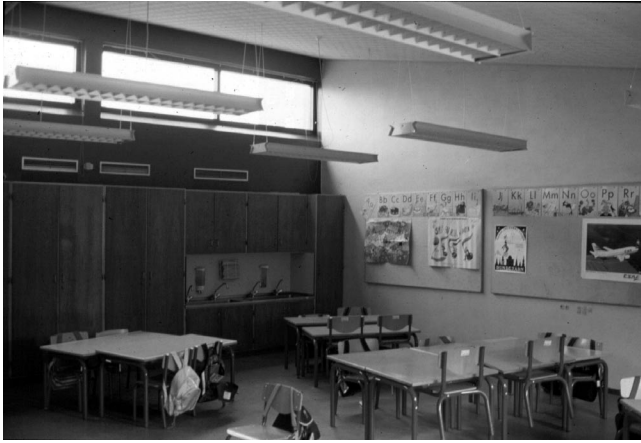
Figur 4.3. Skole B. Klasselokalerne er belyst fra to sider, idet der er et højtsiddende vinduesbånd over dør og skabsvæg i den ene side og et gennemgående vinduesparti ud mod gårdhaven i den modstående væg. Det diagonale lysindfald bevirker, at der kun er få steder i lokalet, som ikke modtager dagslys. De højtsiddende vinduer sender lys ned på vinduespartiet ud mod haven og er på den måde med til at reducere hårde kontraster mellem interiør og udsigt. Til gengæld er der blændingsproblemer ved det højtsiddende vinduesbånd, hvilket dels skyldes, at partiet omkring vinduet er meget mørkt, dels at der ikke er nogen form for afskærmning.
