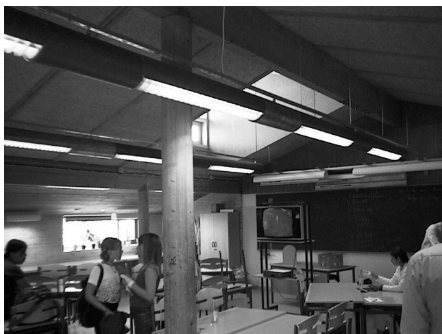
Figur 4.6. Skole N. Hjemklasseområder har ensidigt dagslysindfald fra dels et stort højtiddende "kvist-vindue", dels nogle mindre udsigtsvinduer samt en glasdør i lokalets lavere del. På trods af det forholdsvis store vinduesareal er der problemer med dagslysniveau og -fordeling. Dette skyldes primært vinduernes uensartede placering og størrelse i forhold til lokalernes udformning, hvilket giver store forskelle i lysniveau. Trælammellerne i "kvistvinduerne" burde være lysere og være justerbare, således at de kunne bruges til at styre lysniveauet og reducere eventuel blænding fra himlen. Problemerne med den uensartede lysfordeling forstærkes af materialevalget til vægge i nicher (tegl), lofter (træuldsbeton), og lysning omkring vinduerne (krydsfiner). Dette "rå look" bevirker, at der er en dårlig udnyttelse af reflekslyset, samt at der opstår generende store kontrastforskelle mellem kigget til himlen gennem de højtiddende vinduer og resten af lokalet.
