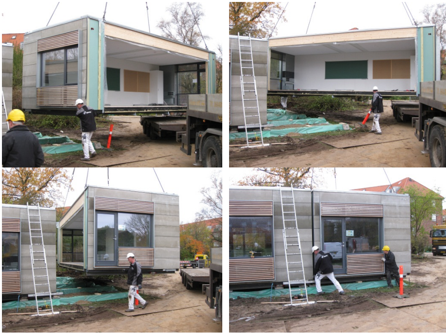
Figur 1. Pavillonmodul aflastes, placeres og 'bygges' sammen med de øvrige moduler. (Foto: Jørgen Rose).
