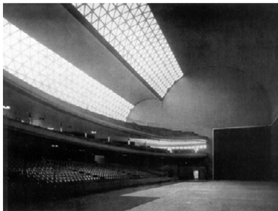
Figur 42. Frontón Recoletos, Madrid 1935. Arkitekt og Ingeniør: Eduardo Torroja. Opført i armeret beton. Grundplan 55x 32,5 m, skaltykkelse 8 cm. (Ordóñez og Vera 1999 p. 144).
