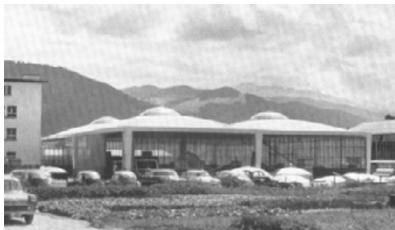
Figur 37. Fabrikshaller, Byggesystem, Schweiz. Arkitekt og Ingeniør: Heinz Isler. Opført i armeret beton. Grundplan pr. skal fx 20 x 14,2 m, skaltykkelse 8 cm (Joedicke 1962 p. 172).
