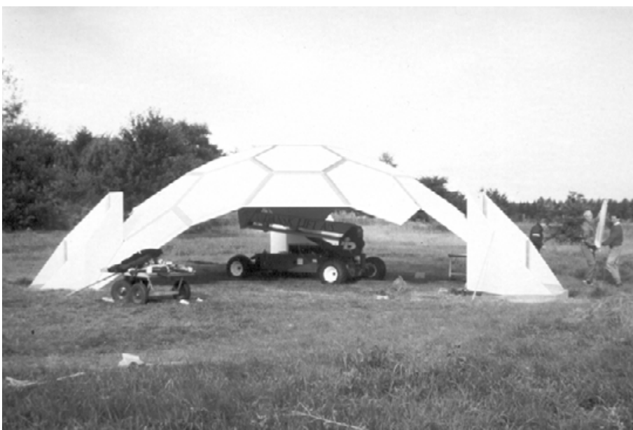
Figur 9.15 a, b og c. Montage af selve skallen foregik ovenfra.
