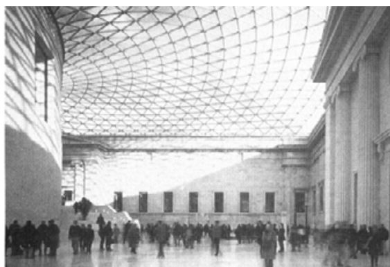
Figur 2. Gitterskal, projektilustration til The great Court, British Museum, London 2000. Arkitekt: Forster & Partners, Ingeniør: Buro Happold (Forster and Partners).
