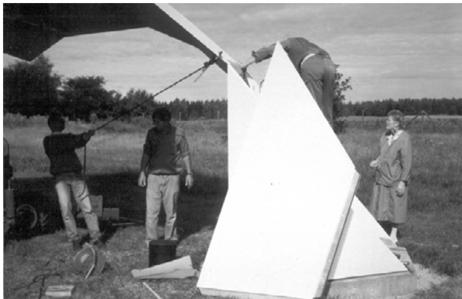
Figur 9.15 d. Montage af skallen på understøtning.
