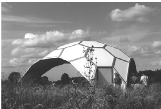
Figur 3. Skiveskal, fuldsalamodel bygget på Statens Byggeforskningsinstitut, Hørsholm 1991. Se Bilag 9.
