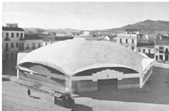
Figur 30. Markedshal i Algeciras, Spanien 1933. Arkitekt: M. Sanchez Arcas, Ingeniør: Eduardo Torroja. Opført i armeret beton. Diameter ca. 44 m, skaltykkelse 9 cm, dog væsentligt mere ved understøtningerne (Joedicke p. 109).
