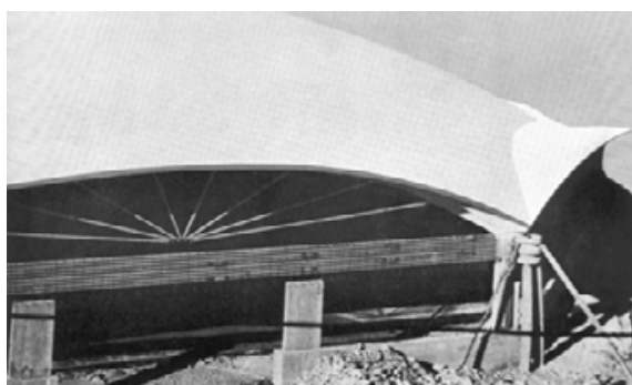
Figur 31. Trækbånd mellem søjler og radiale trækbånd fra cylinderfladen inden udstøbning af bjælke (Joedicke 1962 p. 110).
