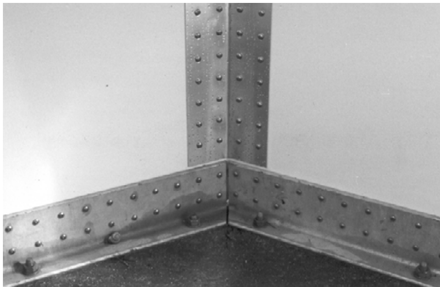
Figur 9.8. Samling mellem lodret skive og fundamentflise.
