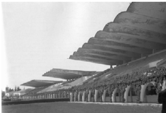
Figur 1. Glatte skaller i armeret beton, tribune på hippodromen i Zarzuela, nær Madrid, 1935. Arkitekter: C. Arniches, M. Dominguez, Ingeniør: Eduardo Torroja (Ordóñez og Vera 1999 p. 115).
