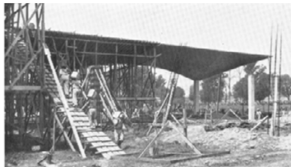
Figur 50. Fabrikshaller, Puente de Vigas. Arkitekt og Ingeniør: Felix Candela. Opført i armeret beton - her ses hvordan betonen bringes op. Grundplan pr. skal 11 x 10 m, skaltykkelse 4 cm (Joedicke 1962 p. 249).
