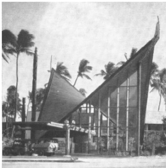
Figur 47. Waikikian Hotel, Honolulu, Hawaii 1958. Arkitekt: G. J. Wimberly & H. L. Cook, Ingeniør: R. R. Bradshaw. Opført i brædder. Rhombeformet grundplan ca. 27 x 15 m, skaltykkelse 6 cm (Joedicke 1962 p. 226).
