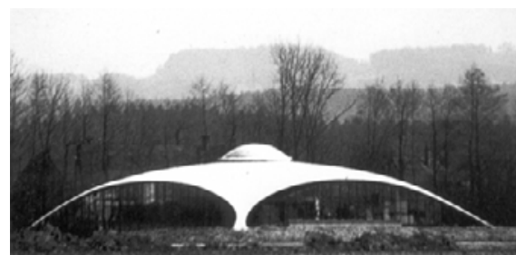
Figur 14. Skal i armeret beton, Garten Center Bürgi, Camorino, Schweiz 1973. Arkitekt og Ingeniør: Heinz Isler (Ramm & Schunk 1986).
