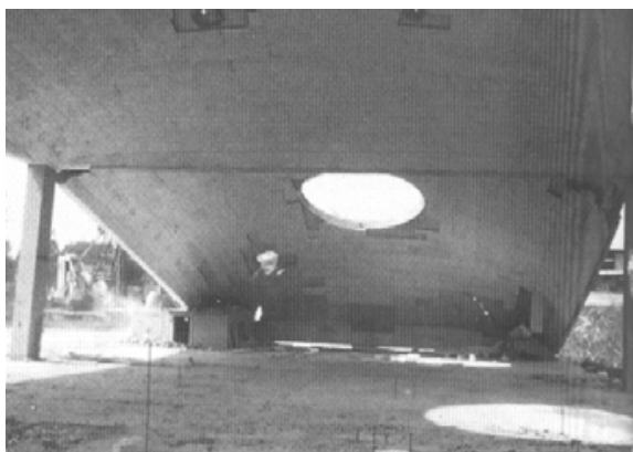
Figur 40. Anden søjle er fjernet, hvorved randen - og dermed skalkfladen - får sin oprindelige form (Robbin 1996 p. 60).
