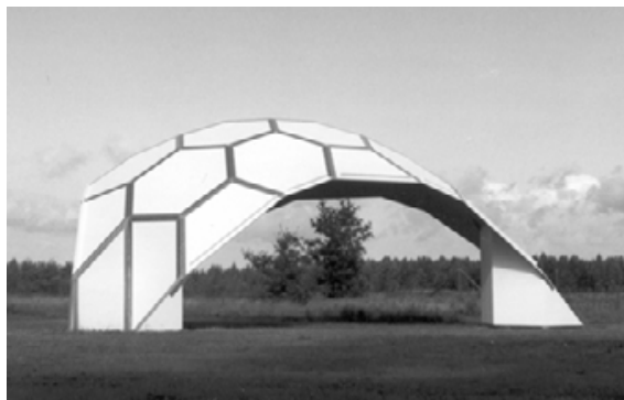
Figur 34. Fuldskalamodel, Hørsholm. Opført i krydsfiner. Trekantet grundplan 11 x 9,5 m, skaltykkelse 2 cm.
