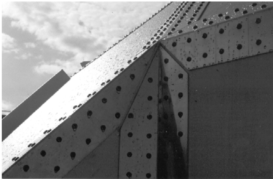
Figur 9.5. Samlingsdetaljer ved understøtningen.
