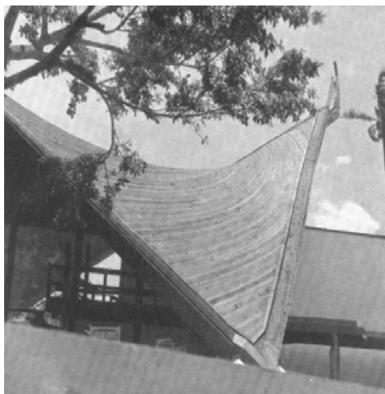
Figur 49. Udsnit, der viser randbjælakens s-form (Joedicke 1962 p. 227).
