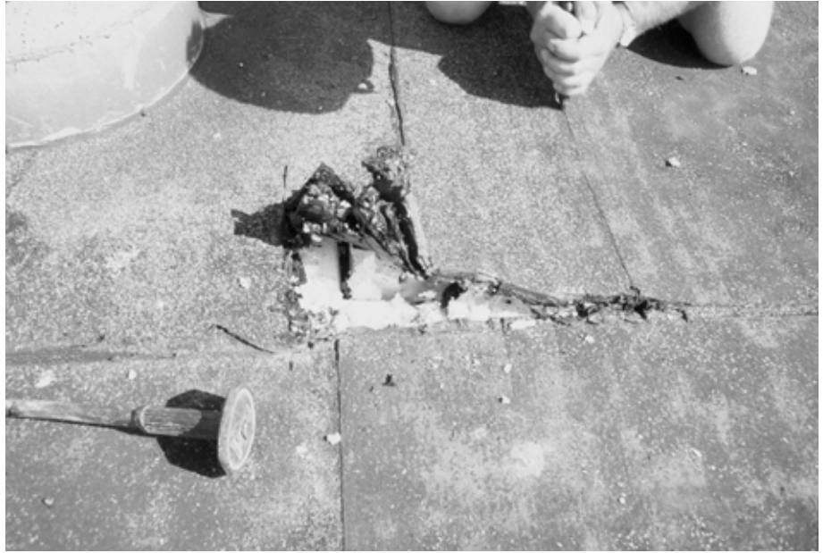
Figur 9. Det øverste lag tagpap er fjernet.
