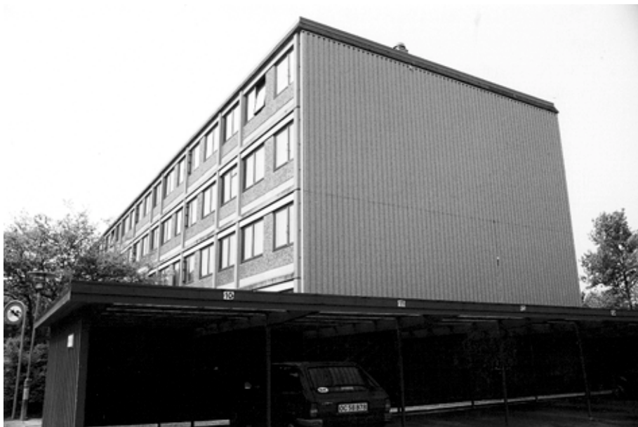
Figur 3. Gavlen er blevet beklædt med Robertsonplade.
