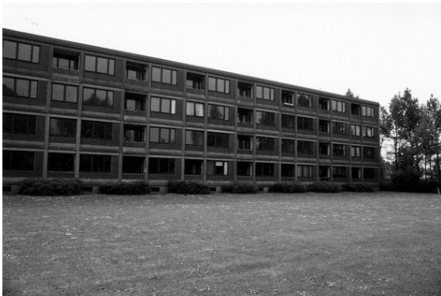
Figur 1. Facade på boligblokken i Rødbyhavn.
