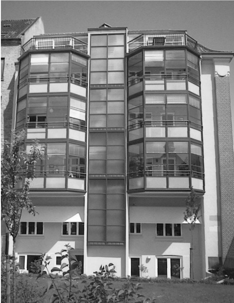
Gårdfacaden på Brandstrupsgade 14, Aalborg, efter at der er opført to tårne med glasinddækkede altaner på hver side af solvæggen.
