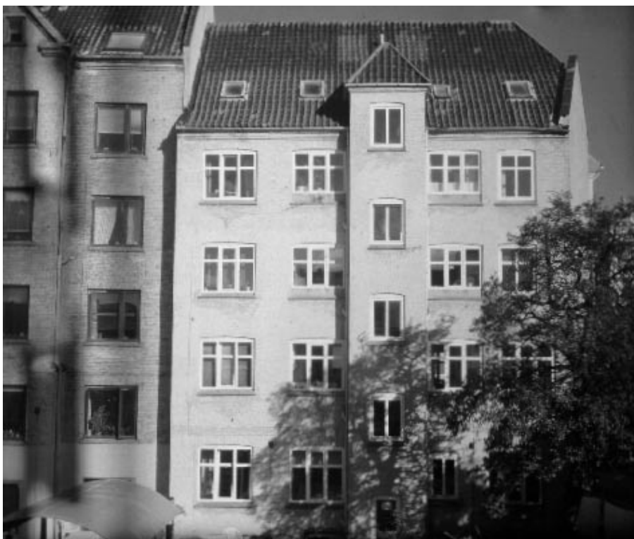
Den syd-sydvest vendte gårdfacade på Brandstrupsgade 14, Aalborg, før renoveringen.
