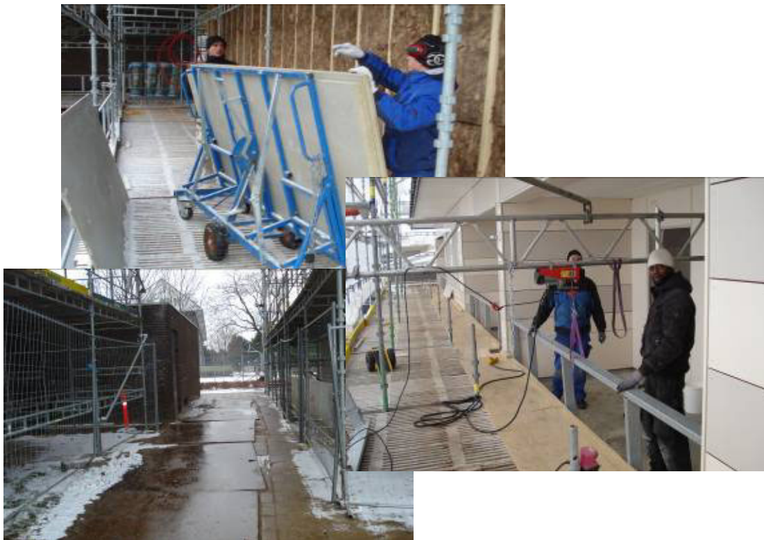
Figur 3. Billeder fra mønsterrunder: Tunge materialer køres på vogne på det brede stillads; Tunge gælændere løftes på plads med elektriske taljer; Ryddede adgangsveje
