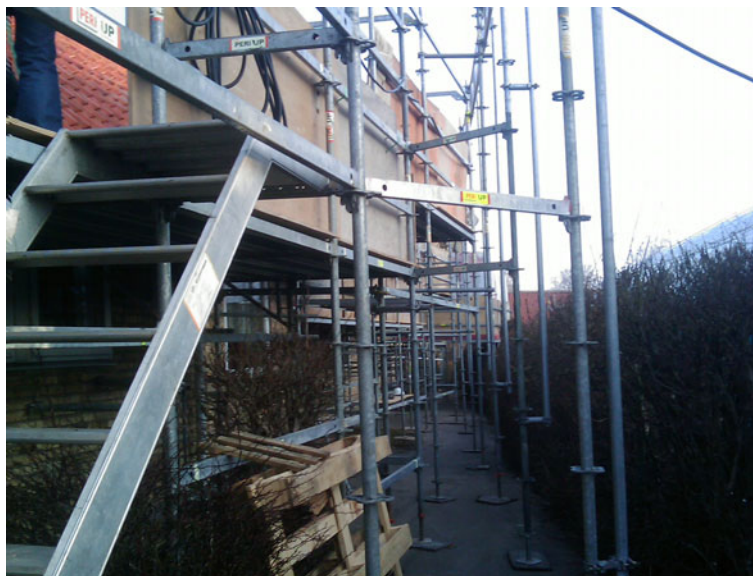
Figur 22. Billede fra byggepladsen
