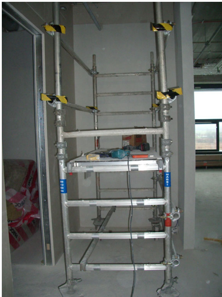
Figur 12. Rullestativ med rækværk på de tre sider – udviklet til projektet
