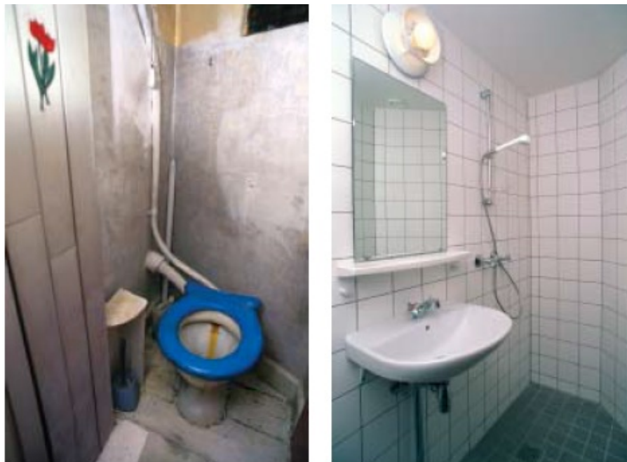
Figur 2. Toilet i etageejendom hhv. før (kun toilet) og efter (toilet og bad) renovering.
