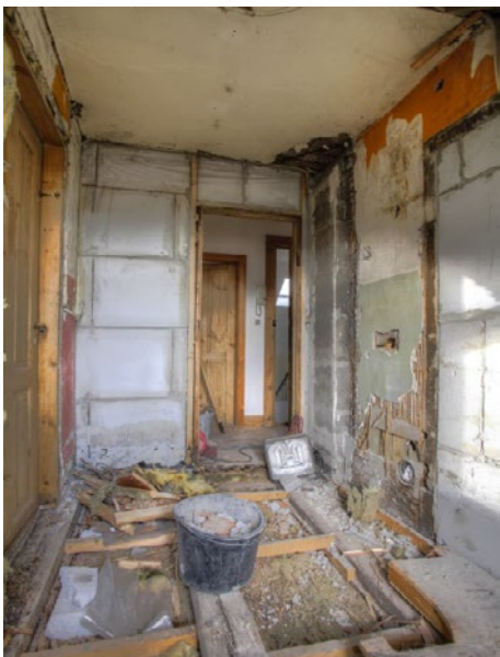
Figur 76. Badeværelse under nedbrydning og klargøring for opbygning af dobbelt gulv.
