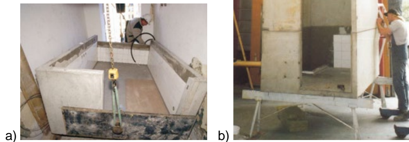
Figur 38. a) Præfabrikerede beton "kar" med en højde på 850 mm. b) Samling af bund og vægge på forsøgsbadeværelse.
