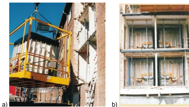
Figur 30. a) Montage af en badeværelseskabine, der skal føres vandret ind i bygningen i et eksisterende værelse. b) Fire badeværelser som er placeret i bygningen, hvor stålskelet og installationer tydeligt ses inden der opbygges vægge med skaktadgang.
