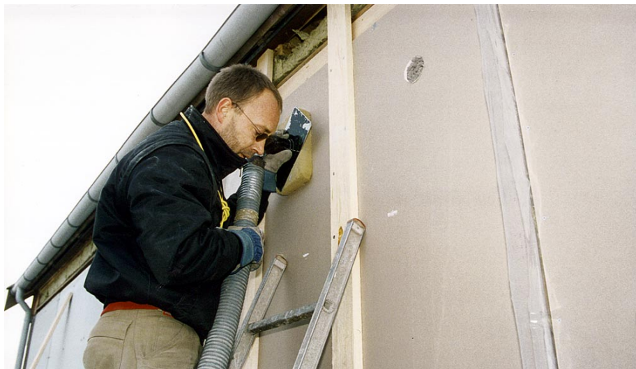
Figur 9. Indblæsning af Papiruld i element 4B.
