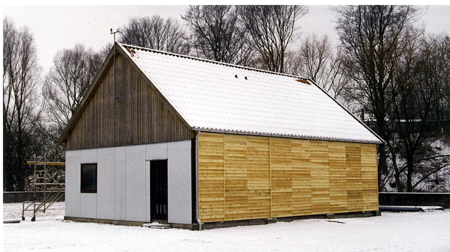
Figur 1. Fugtforsøgshuset set fra nordøst en vinterdag. Facaden vender mod nord og gavlen mod øst.
