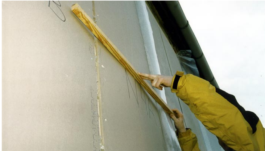
Figur 8. Udbøjning af gipsplade efter indblæsning af Papiruld i element 4A.
