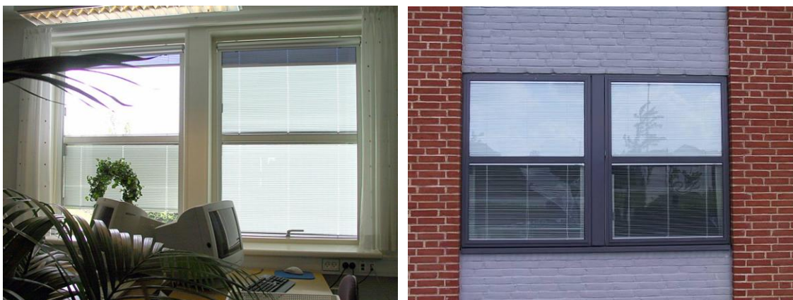
Figur 35. Indvendig og udvendig foto af eksisterende solafskærmning. Afskærmningen består af en indvendig persienne, en indvendig film (blå) og et almindeligt gardin. Persiennen kunne styres individuelt i det øvre og nedre vindue, men de nuværende brugere var utilfredse med denne løsning, hvilket ofte medførte overtemperaturer om sommeren.
