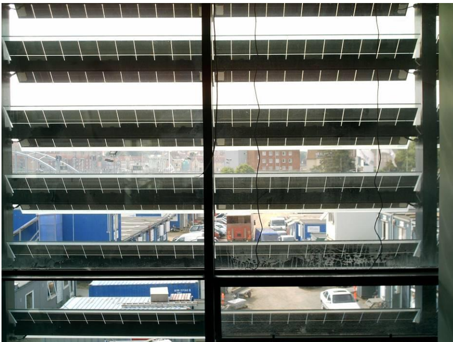
Figur 55. Persienne med solarceller.
