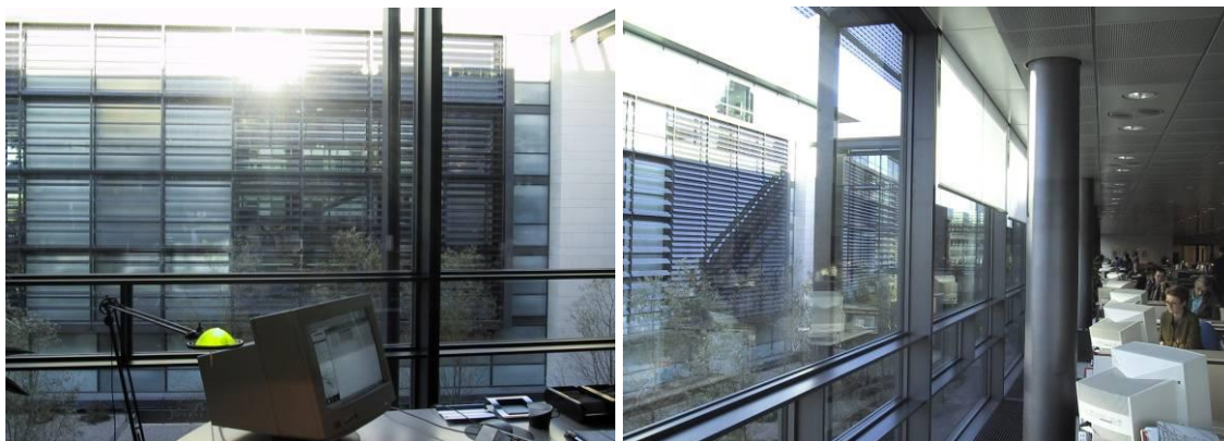
Figur 5. Udsigt gennem nordfacader i en kontorbygning. På grund af generende reflekser fra sydfacaden af den modstående bygning, har det været nødvendigt at montere indvendige screen mod nord.
