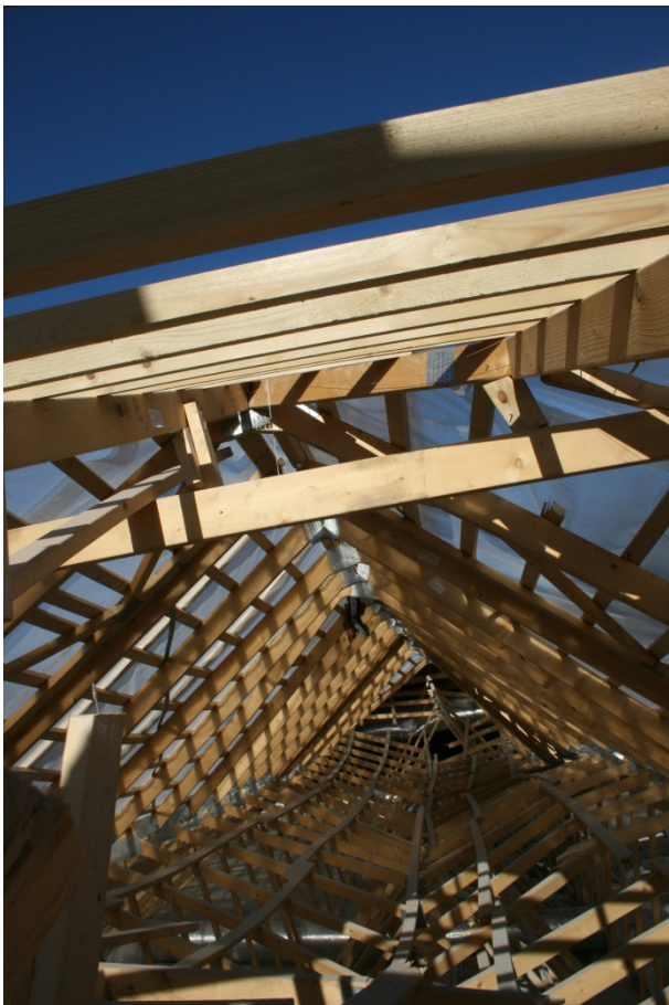
Figur 15. Samlet udknækning af hanebånd. Foto: SBI.
