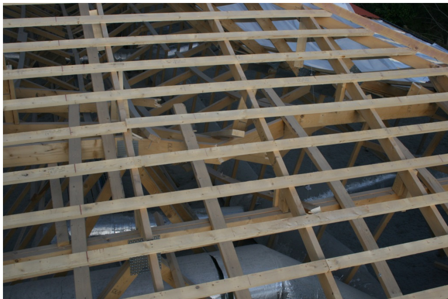
Figur 17. Lægte i tagflade til forankring af langsgående afstivning. Foto: SBI.
