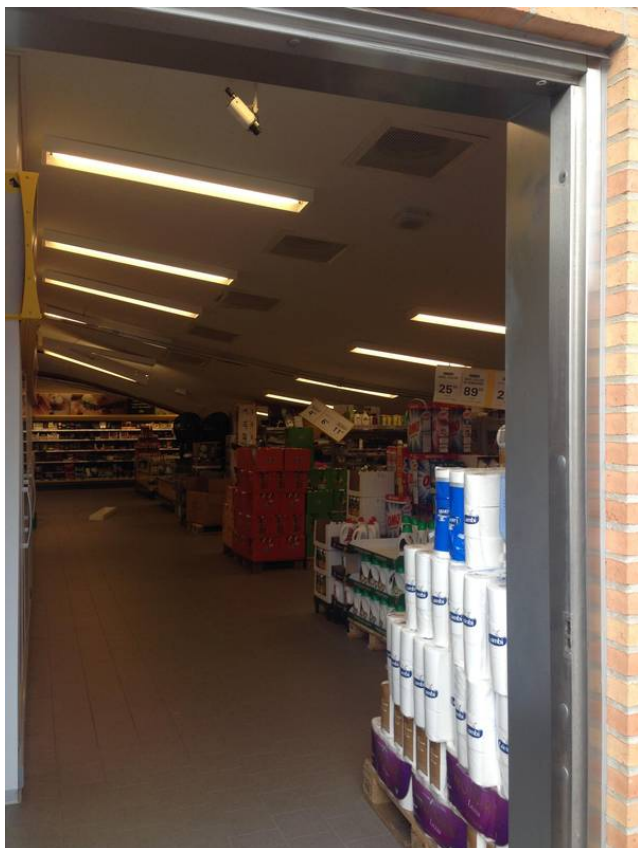
Figur 4. Butiksinteriør umiddelbart efter kollapset. Foto: Privat foto. (Ekstra Bladet, 2016).
