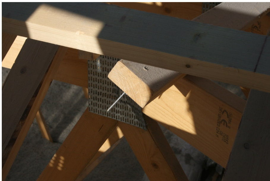
Figur 18. Længdeafstivning med 1 skrue. Foto: SBI.
