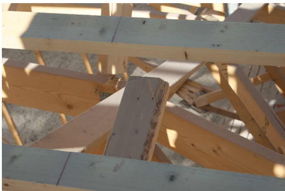
Figur 19. Lægte i afvalmet tagflade fastgjort med 2 skruer. Foto: SBI.
