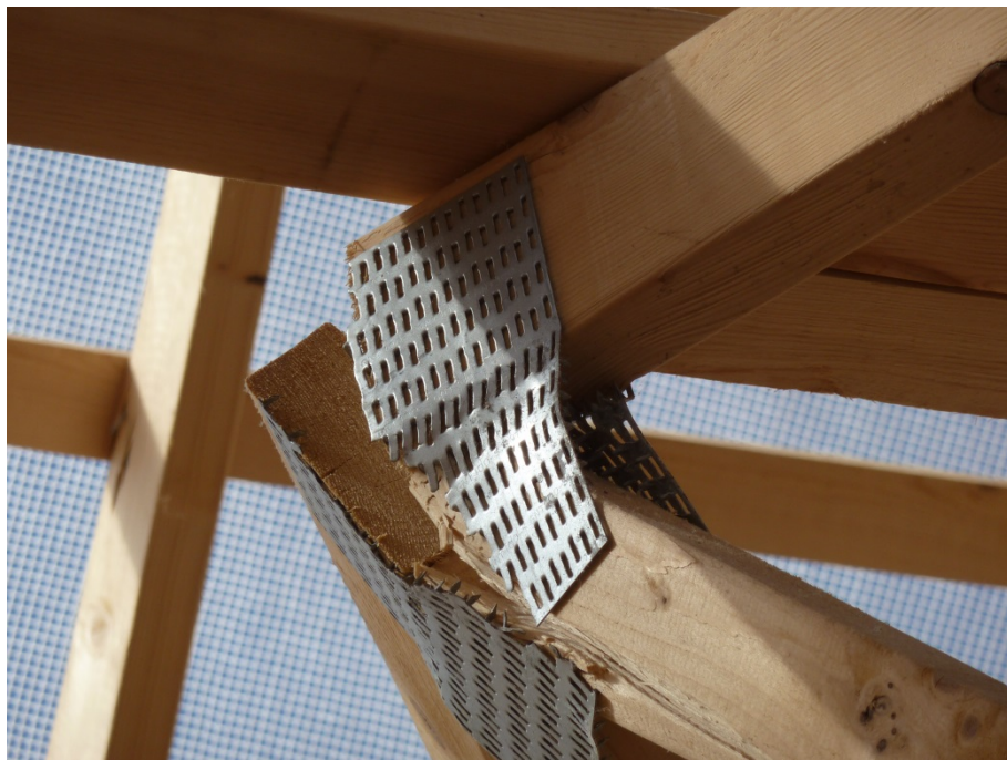
Figur 22. Hanebåndet er delt ved bygningen midte. Foto: SBI.
