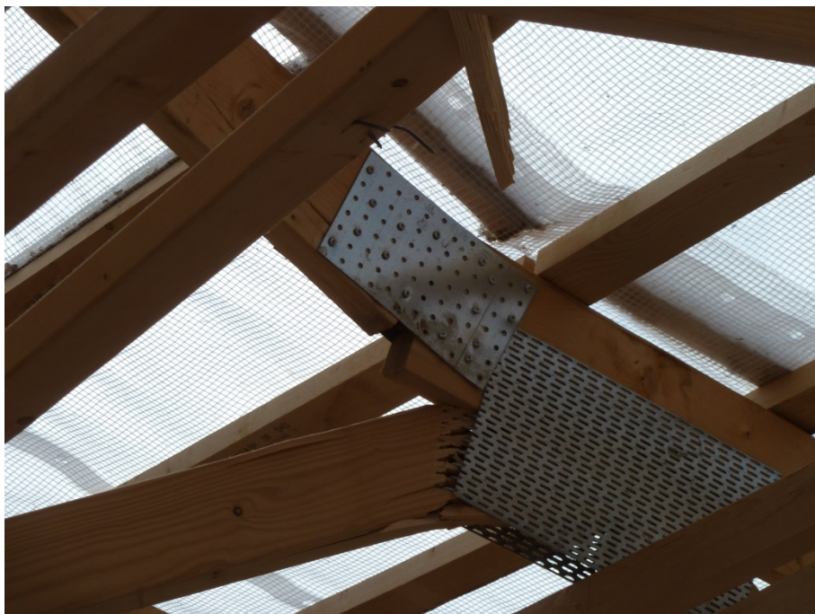
Figur 20. Eftermontering af løs top over hanebånd. Foto: SBI.
