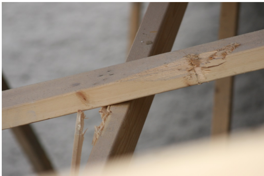
Figur 14. Sømning tæt på kant af hanebånd. Foto: SBI.
