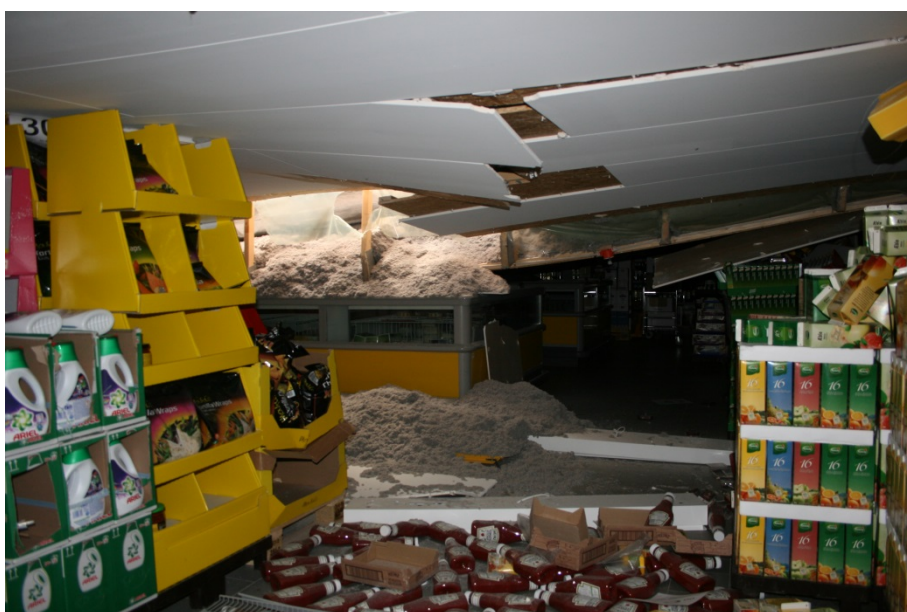
Figur 5. Butiksinteriør, hvor spæret ligger på køledisken, 18 dage efter kollapset. Foto:SBI.
