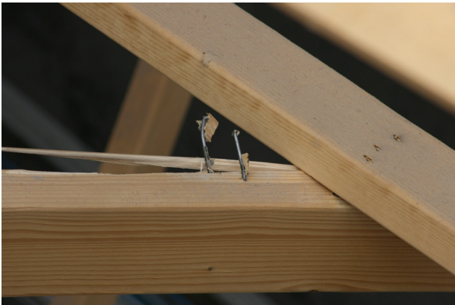
Figur 11. Sømning tæt på kant af hanebånd. Foto: SBI.
