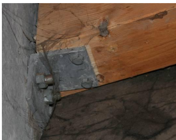
Billede A10. Næsten intakt fastgørelse af randbjælken i østlig side.
