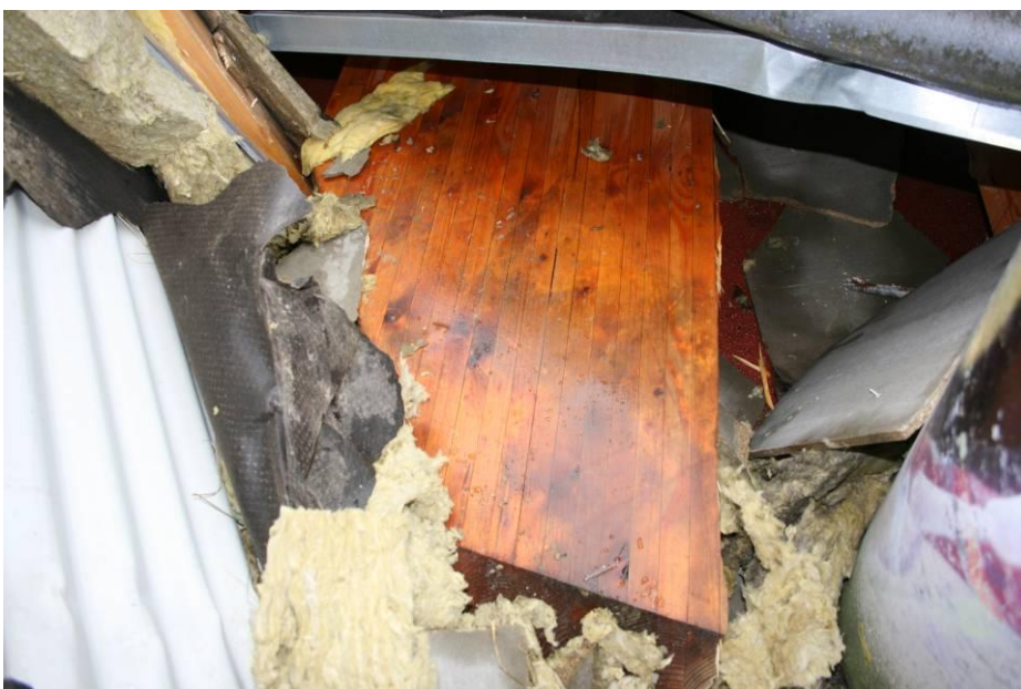
Billede A5. Buen i systemlinje 9 er flækket ind fra endefluden.
