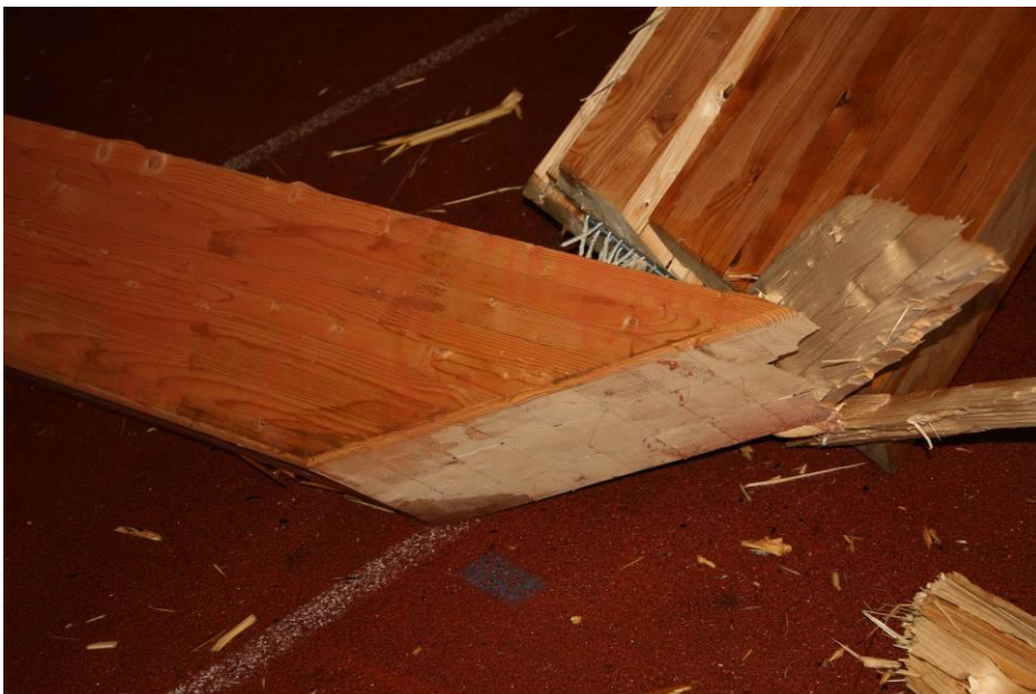
Billede A4. Buen i systemlinje 8, nederste del ('underflangen'). Øverst til højre ses en ås.
