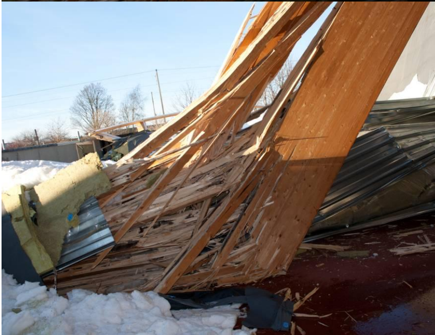
Billede A1. Bue med typisk svigt. Øverst ses at buen er flækket på langs, og nederst ses bøjningsbrud.
