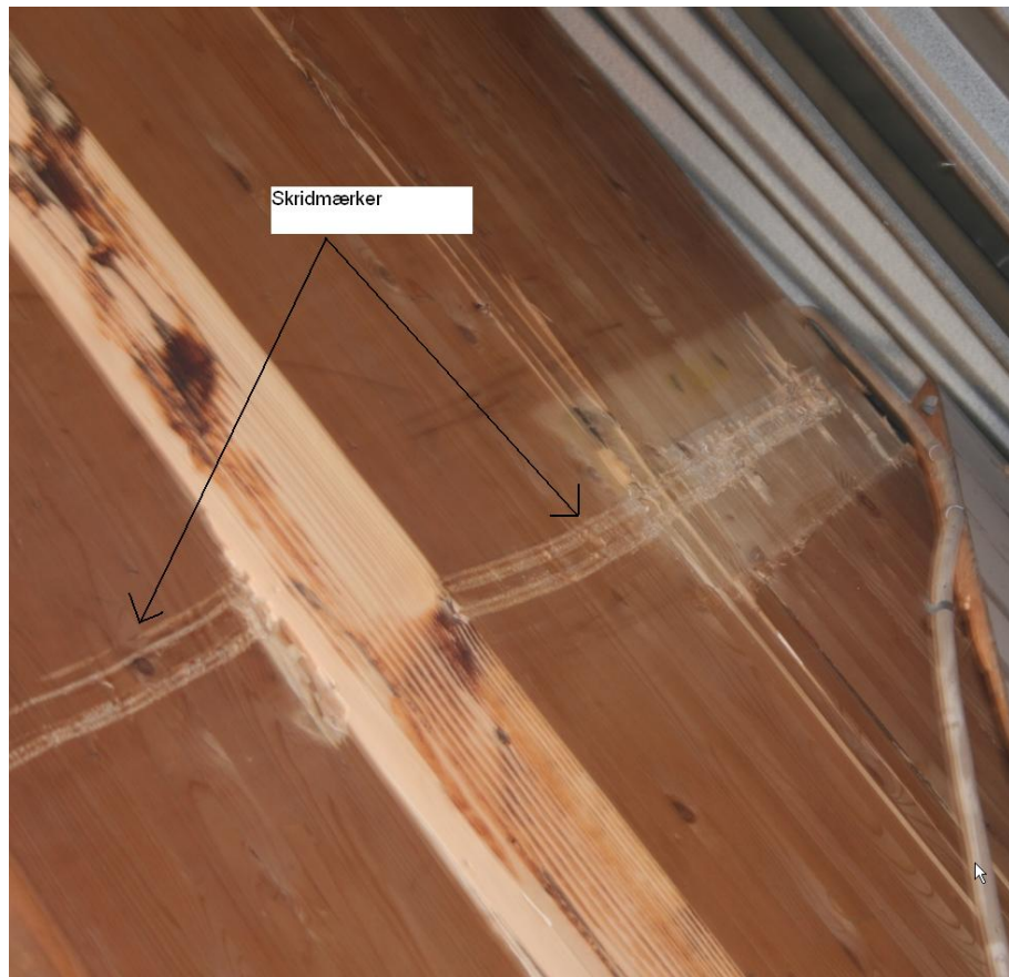
Billede A6. Skridmærker på flækket bue i systemlinje 10 fra nedfaldet ås.
