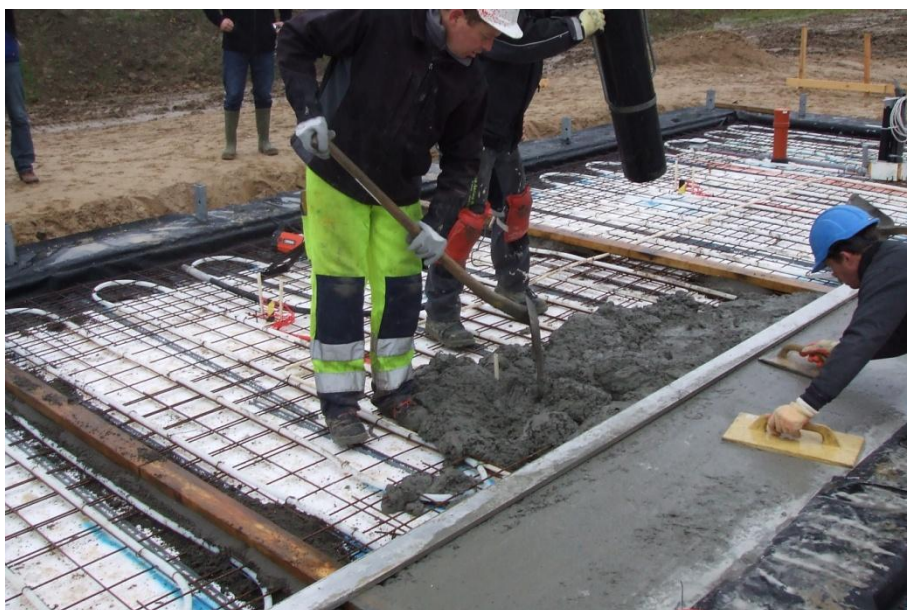
Figur 4. Udstøbning af betondæk der indeholder faseskiftende materialer.
