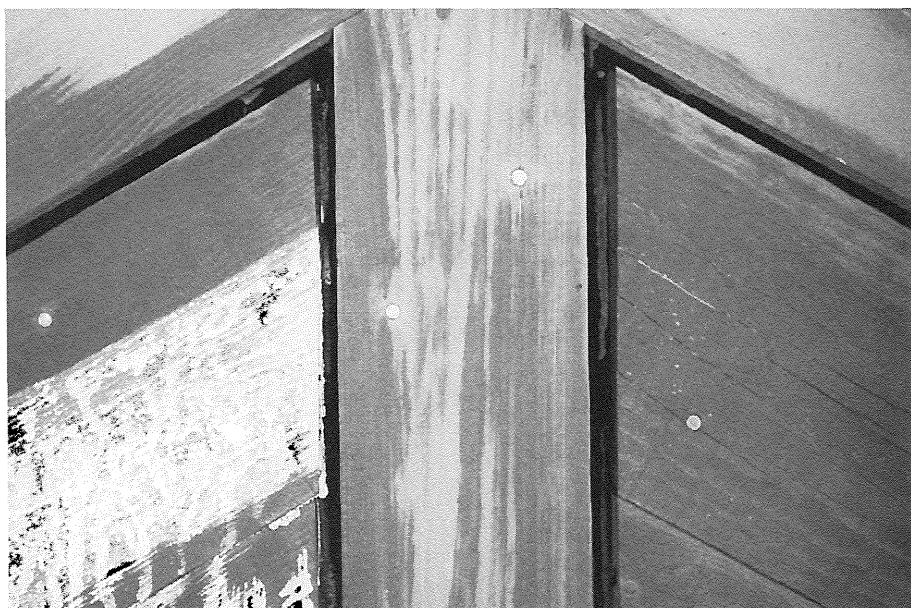
Figur 25. "De fire årstider": Spidsafslutning af brædde- beklædning efter 5½ må- neds ældning.
