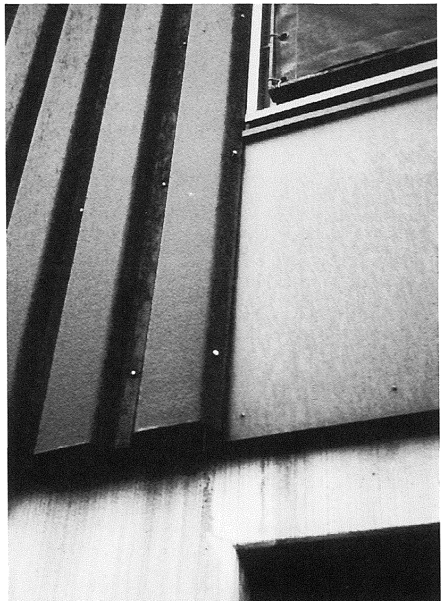
Figur 5 og 6. Tilstandsregistrering: Stålbladebeklædning på træskelet, og indbygning af snedkerparti. Stålbladerne op til 10 m lange, hvilket kan give en temperaturbetinget længdeændring på godt 1 cm.
