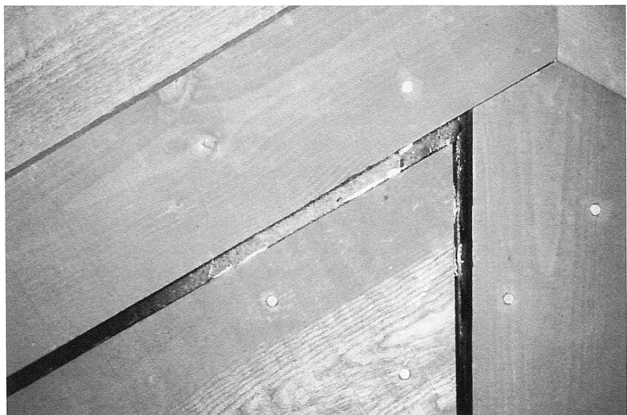
Figur 22. "De fire årstider": Spidsafslutning af brædde- beklædning inden ældning.
