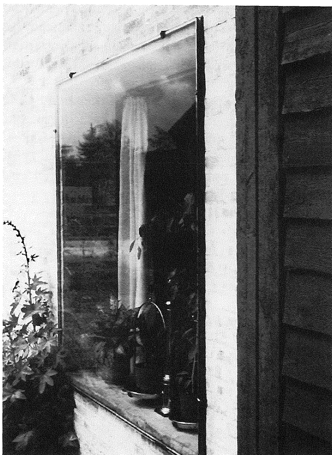
Figur 8. Tilstandsregistrering: Sammenbygningsdetalje mellem træ og tegl.
