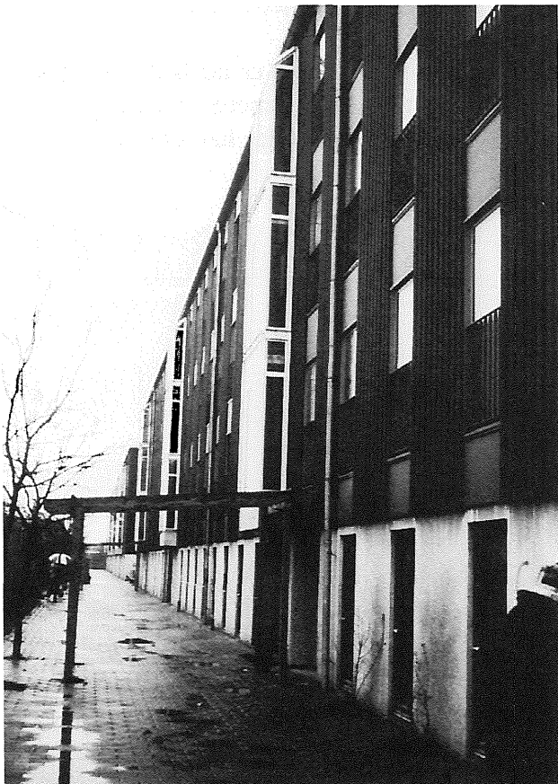
Figur 5 og 6. Tilstandsregistrering: Stålbladebeklædning på træskelet, og indbygning af snedkerparti. Stålbladerne op til 10 m lange, hvilket kan give en temperaturbetinget længdeændring på godt 1 cm.
