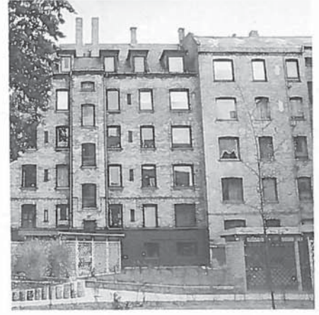
Gårdfacaden før renoveringen.
