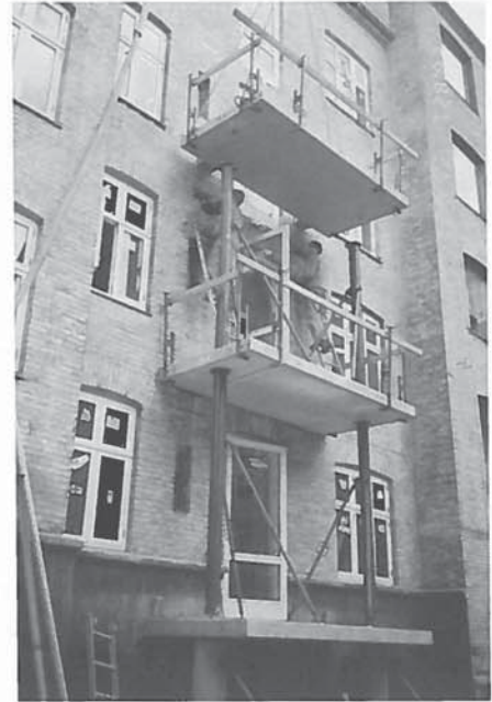
Montage af altandæk.
