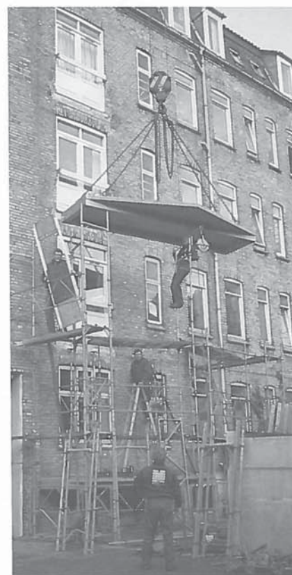
Montage af altandæk.
