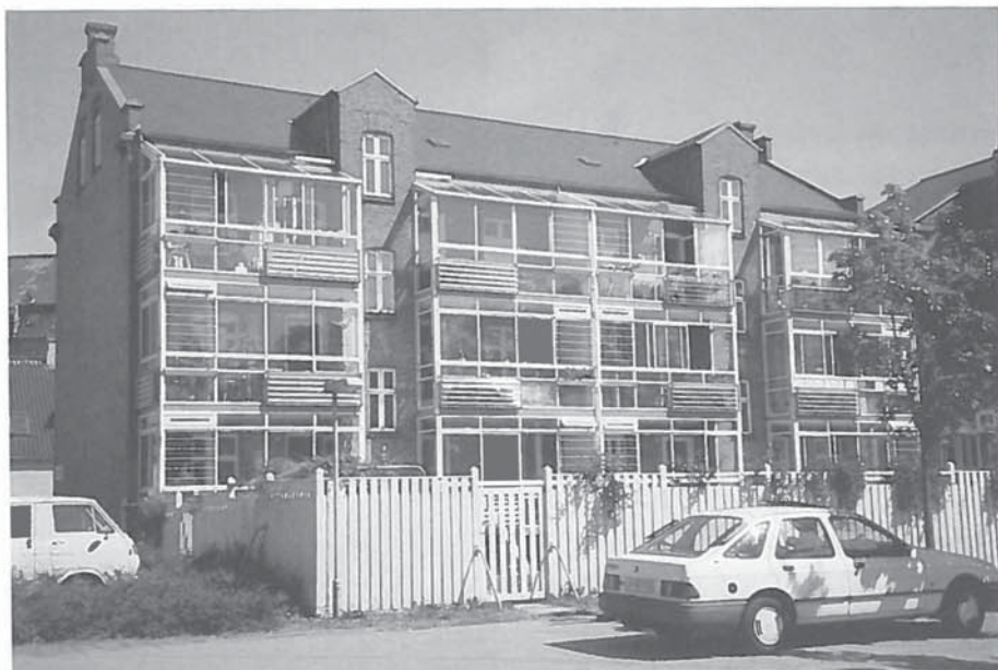
Ole Rømers Gade 38-42, gårdfacaden.
