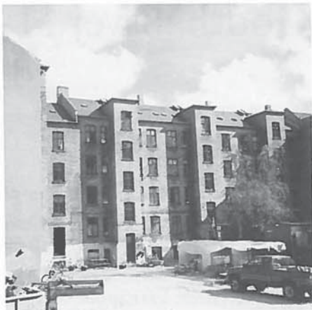
Gårdfacaden før renoveringen.
