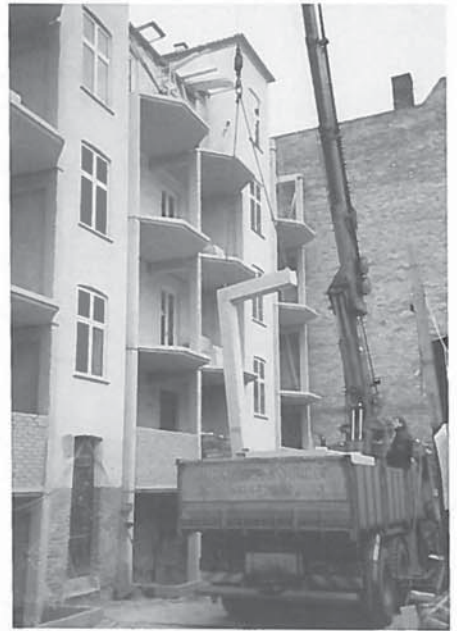
Montage af betonstragere.
