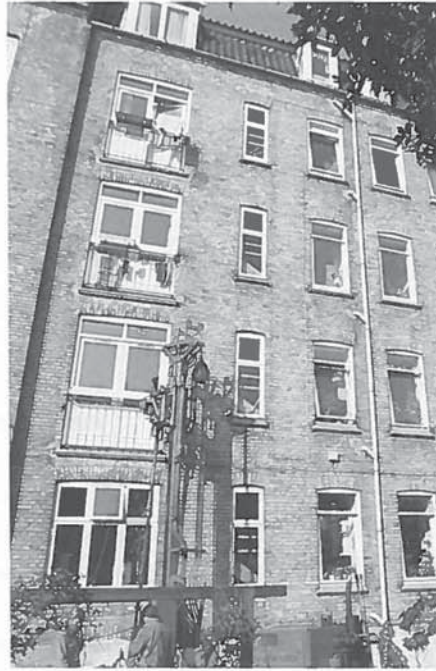
Gårdfacaden før renoveringen.
