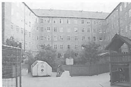
Gårdfacaden før renoveringen.
