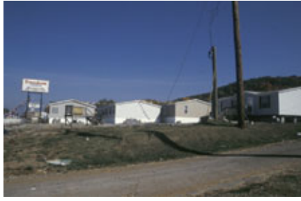
Figur 20. Der har været talrige forsøg på først og fremmest småhusbyggeri baseret på store, lette (rumstore) enheder der hurtigt og rationelt kunne monteres på punktfundamenter på stedet. Hvorfor bygger vi stadig så tungt og i så høj grad på stedet? "Mobil homes", USA. (Foto: Line Eriksen).
