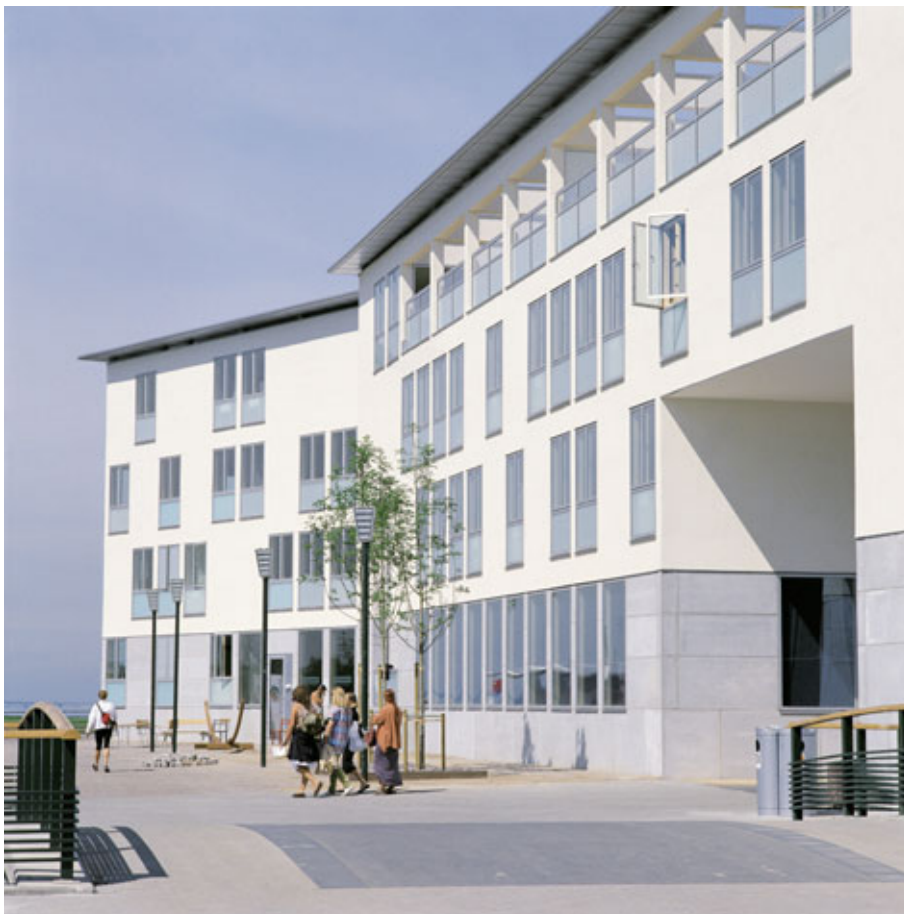
Figur 14. Velfacvinduet tilbyder stort glasareal for hulmålet. Vand, kondens, kuldebroer og slitage er løst i et kompliceret profilsystem. Det er et produktsystem med en lukket syntaks for mulige varianter, som omvendt danner et kontinuum af individuelle leverancer. (Foto: VELFAC A/S).
