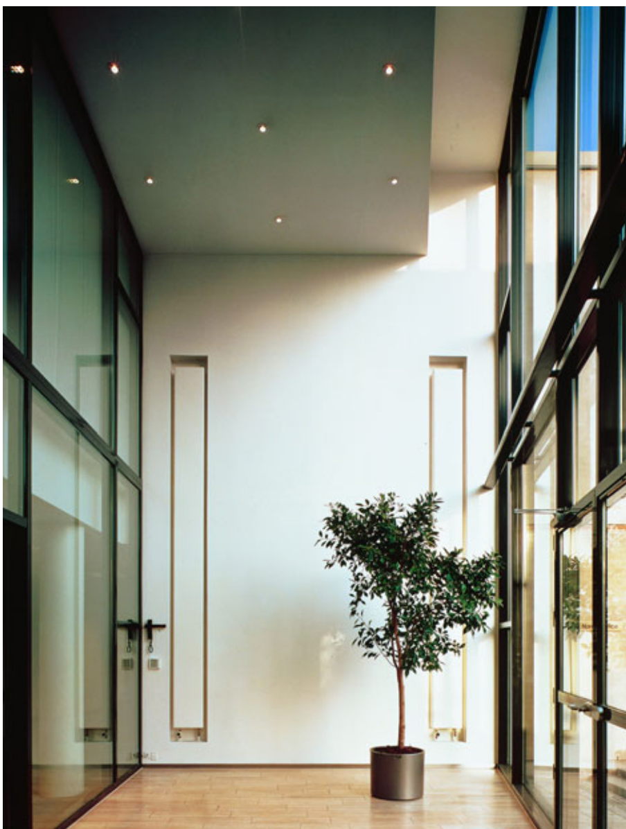
Figur 38. Rigtigt anvendt kan radiatorer sagtens indgå i den arkitektoniske helhed. I dette indgangsløse skabes den stramme symmetri af to høje, smalle Hudevad radiatorer, fældet ind i nicher.
