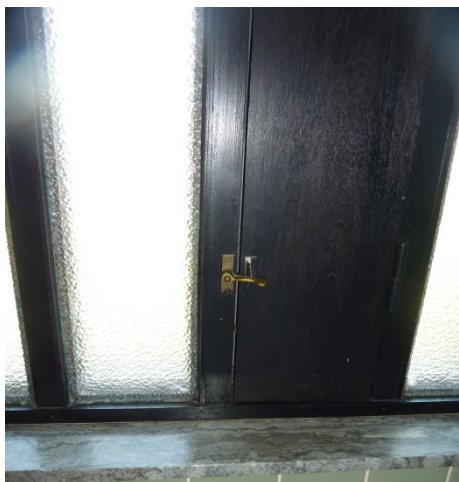
Figur 8. Blændparti til udluftning i parcel-/typehus fra perioden 1960-1976.
