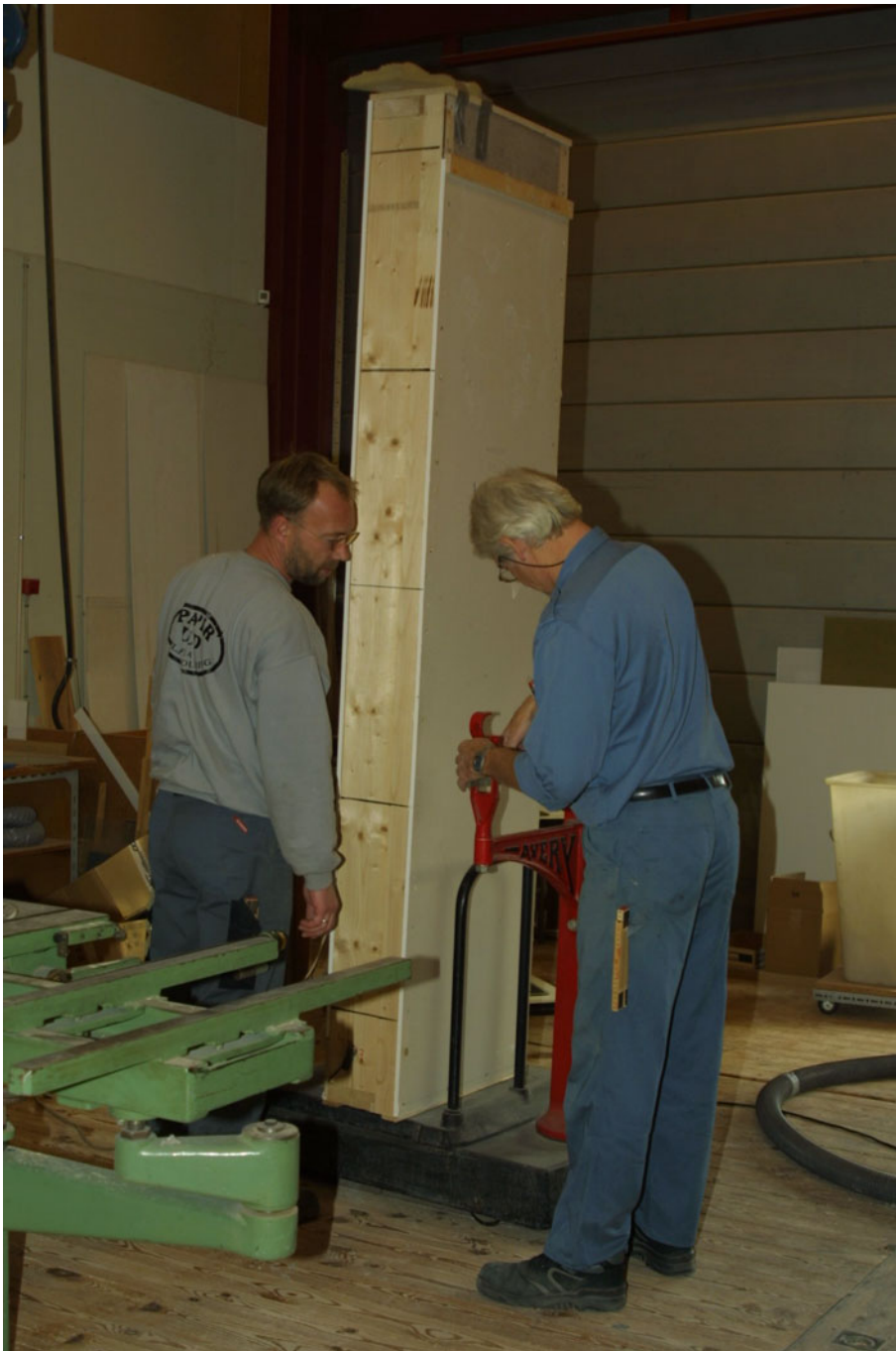
Figur 10. Efter endt indblæsning vejes væggen for at bestemme den omtrentlige gennemsnitlige densitet. I det viste tilfælde er Papiruld indblæst i form af løsfyldsisolering i en væg med de indvendige dimensioner: længde \times tykkelse \times højde lig med 0,495 \text{ m} \times 0,198 \text{ m} \times 2,3 \text{ m} uden lægter. Den endelige beregnede gennemsnitlige densitet af løsfyldsisoleringen relateres til 50 % relativ luftfugtighed og 23 \text{ }^\circ\text{C} . Løsfyldsisoleringen konditioneres i klimarum.
