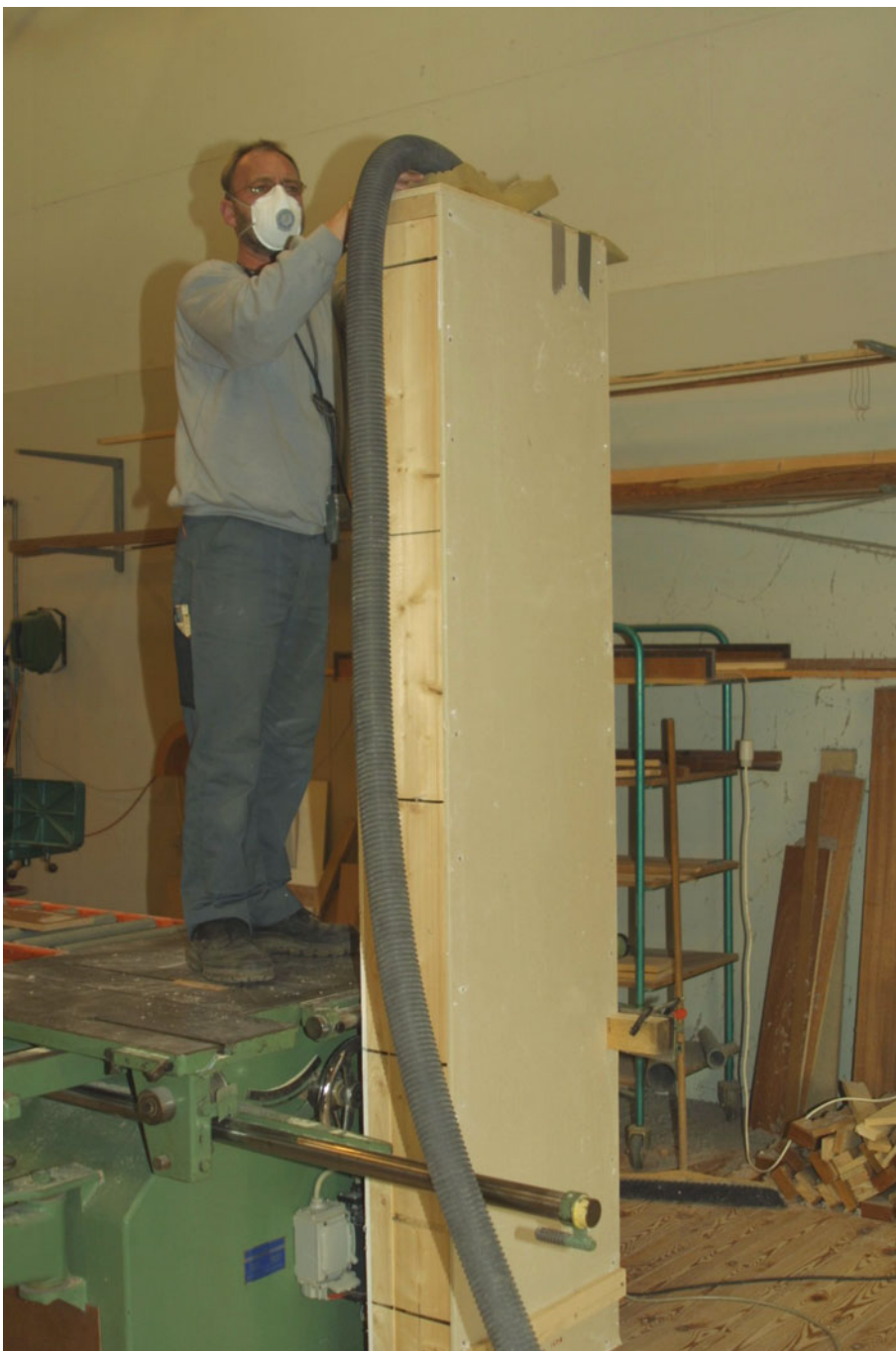
Figur 7. Indblæsning af Papiruld i en væg beklædt med gipsplade. Væggen er en lukket kasse forsynet med top- og bundrem. Topremmen er forsynet med huller. Et hul er placeret centralt i topremmen og bruges til at stikke fødeslangen ned i væggen. Ved siden af hullet til fødeslangen er der placeret huller til luftudtag. Under indblæsningen afdækkes hullerne med polyuretanskum. Før indblæsningen påbegyndes føres fødeslangens munding ned til væggenes bundrem. Under indblæsningen trækkes slangen gradvist op. Væggen er fastholdt under indblæsningen. I det viste tilfælde indblæses løsfyldsisoleringen i en væg med de indvendige dimensioner: længde \times tykkelse \times højde lig med 0,495 \text{ m} \times 0,198 \text{ m} \times 2,3 \text{ m} uden lægter.
