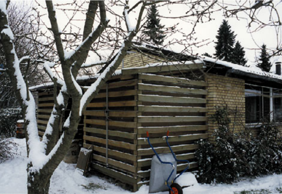
Figur 8. Nordfacade, gavltrekan- ten. Overfladetemperaturen var ens, 2,1 °C på hele gavltrekan- ten.
