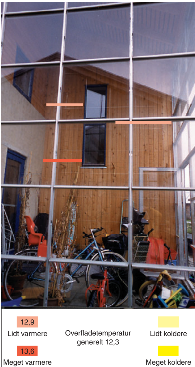
Figur 26. Væg bag glasfacader.
