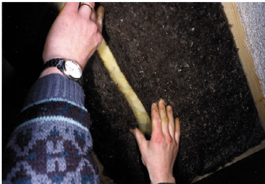
Figur 40. Loftplade er nedtaget. Isoleringen af fåreuld når ikke sammen på midten.
