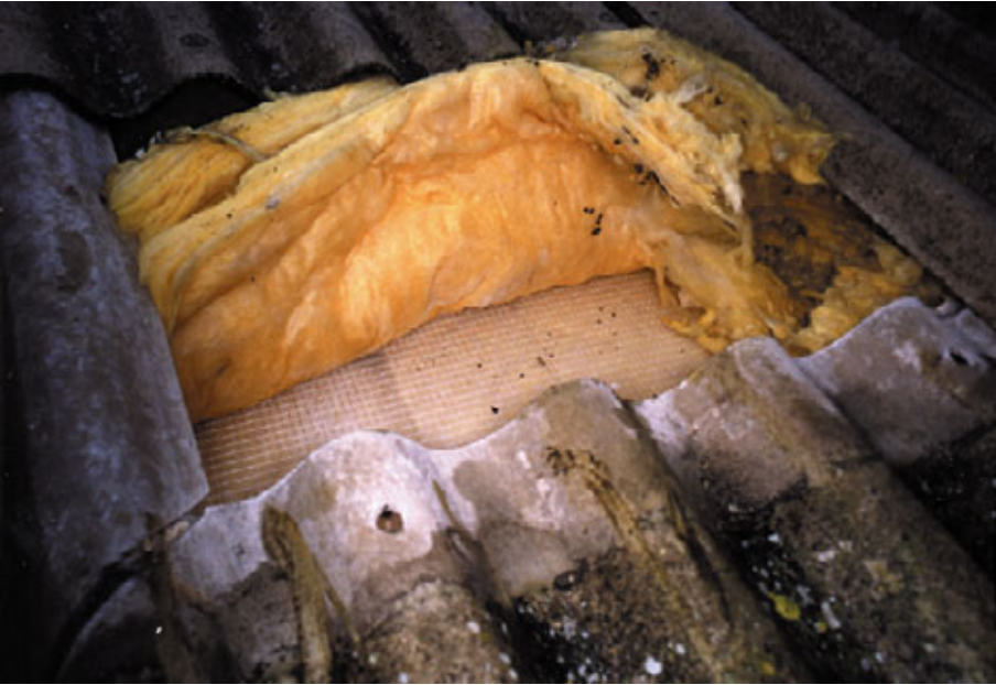
Figur 37. Bølgeeternitplade fjernet (tag mod mark).
