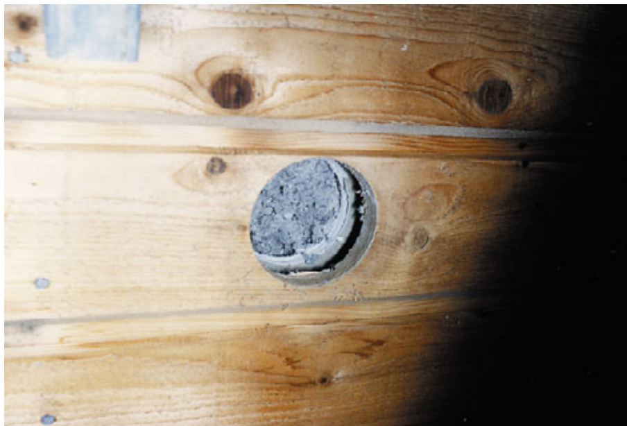
Figur 27. Hul boret ved tag på et sted hvor der var højere temperatur end på resten af væggen.
