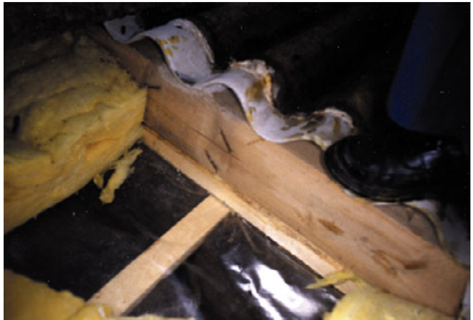
Figur 36. Bølgeeternitplade fjernet (tag mod stuehus).
