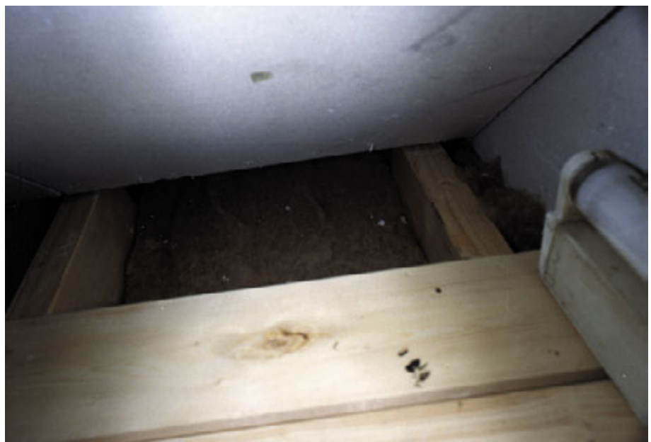
Figur 54. Isoleringsmaterialet i etageadskillelsen i pulterrum.
