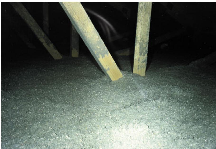
Figur 78. Ekofiber Vind udblæst på loft.
