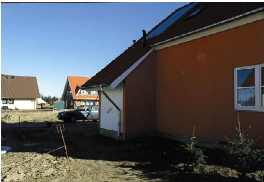
Figur 51. Facade mod vest. Termografering viste at vægområdet med vindue havde en generel overfladetemperatur på 5,4 °C, mens vægområdet med træbeklædning havde en generel overfladetemperatur på 5,0 °C.
