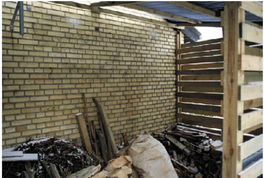
Figur 7. Nordgavl, området dækket af brændeskur. Temperaturen var ens 1,8 °C over hele vægfladen.
