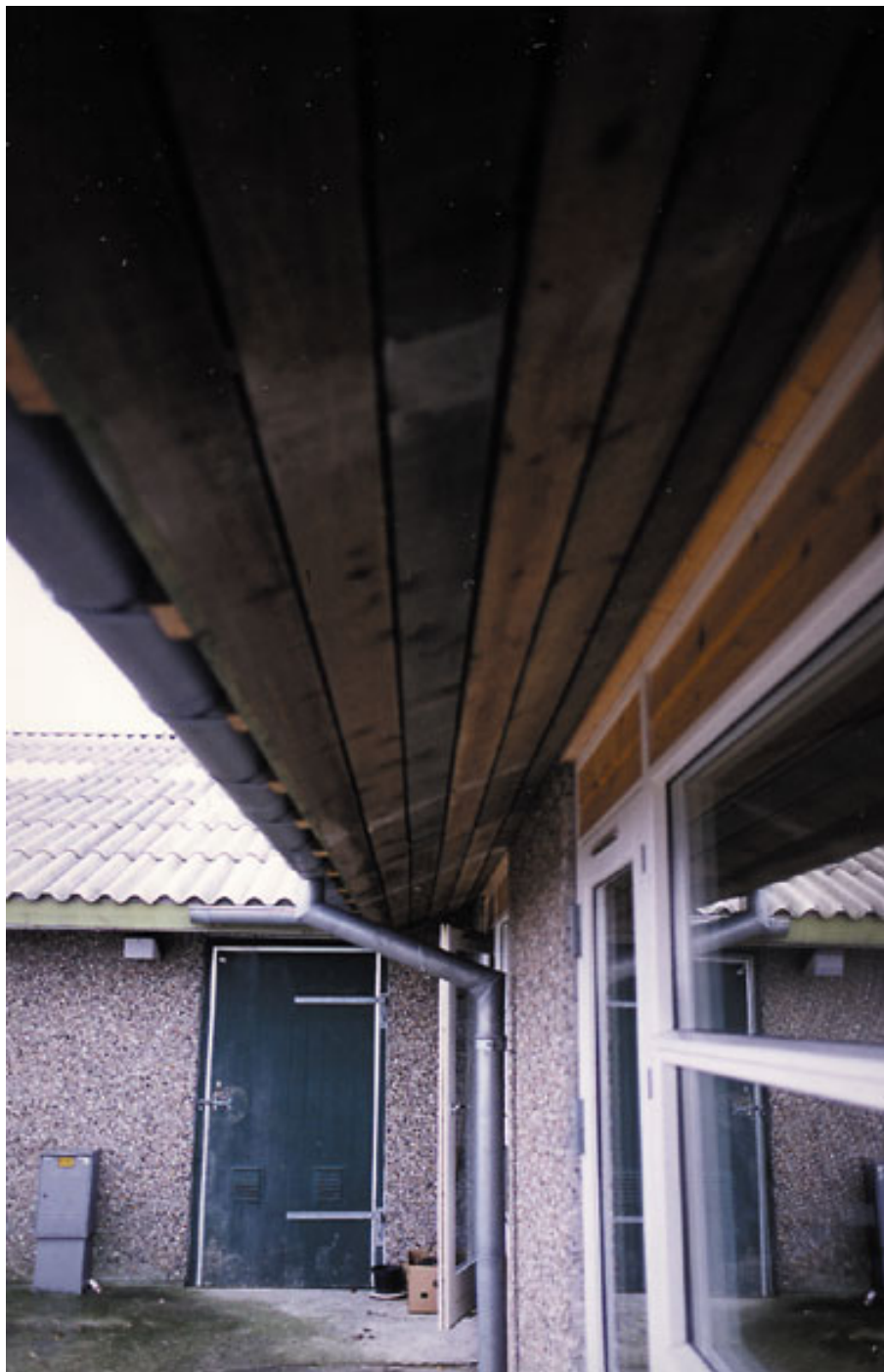
Figur 43. Udhængsbrædder mod mark.
