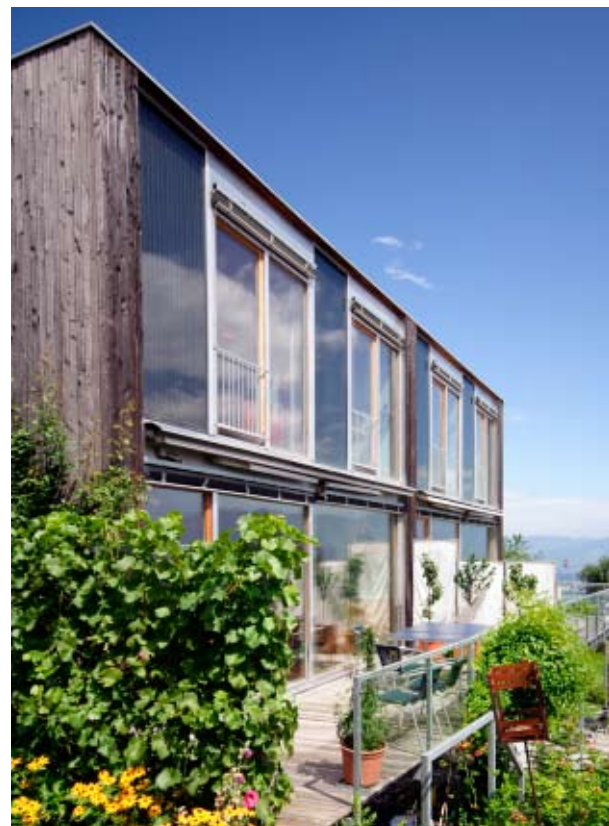
Lavenergirækkehuse, Batschuns Walter Unterrainer, 1998
