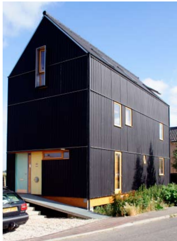
Dagslys, solvarme, råhus og teknik skal spille sammen i fremtidens lavenergiarkitektur The Black House, Prickwillow Mole Architects, 2004
