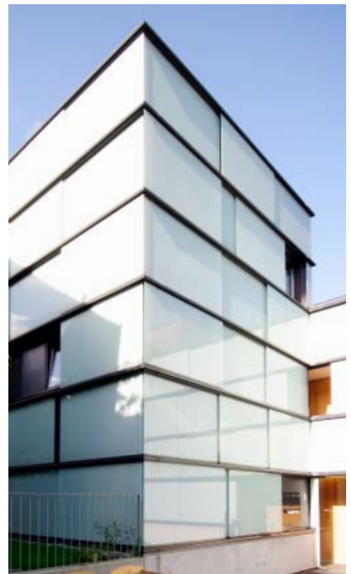
Let og højisoleret træfacade med glas som regnskærm Sebastianstrasse, Dornbirn Baumschlagel & Eberle, 2002
